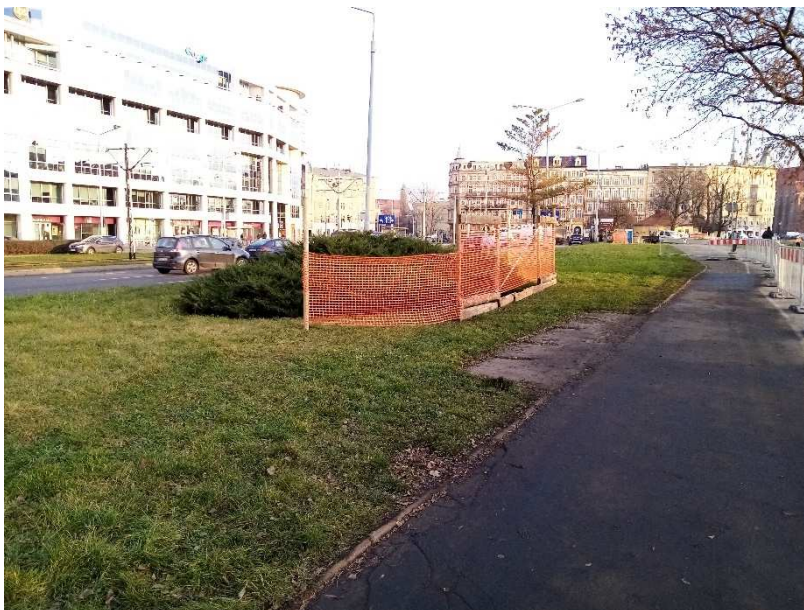
Fot. 1. Przykład wygrodzenia chroniącego grupy krzewów przed zasypaniem (Wykonanie i fotografie K. Barski).
