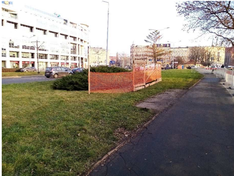
Fot. 1. Przykład wygradzenia chroniącego grupę krzewów przed zasypaniem (Wykonanie i fotografie K. Barski).
