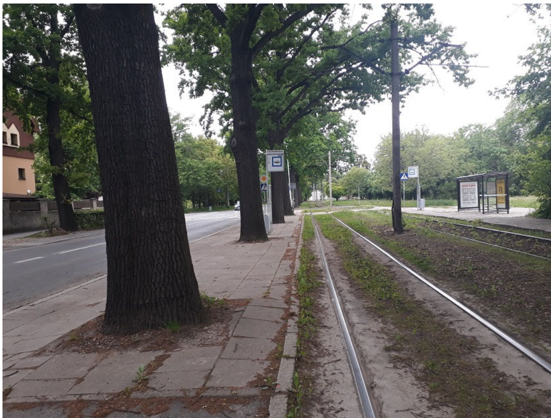
Fot. 6. Widok na perony tramwajowe w ul. Olszewskiego i istniejący drzewostan. Widok w kierunku zachodnim na wys. drzewa o nr inw. 4.
