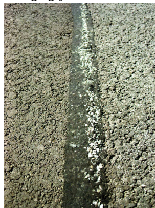
Rys. 4. Wykonanie złącza podłużnego metodą „gorące przy zimnym” bez zastosowania materiału uszczelniającego złącze, np. bez taśmy topliwiej (Sposób niezalecany na drogach publicznych. Może być stosowany tylko wyjątkowo za zgodą Inżyniera, np. na krótkich odcinkach lub w warunkach specjalnych)
