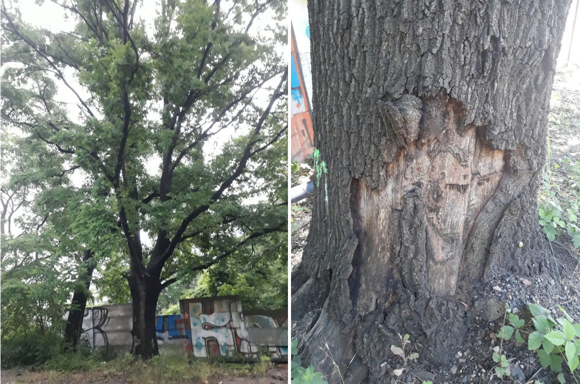
Fot. 12. Drzewo o nr inw. 11. Rana z martwicą od str. E. Brzegi zakallusowane.
