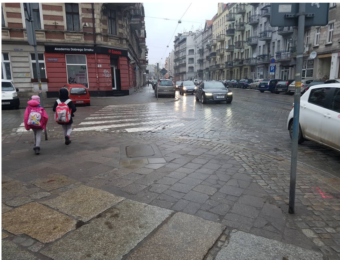
Rysunek 2 Chodnik przy skrzyżowaniu ul. Kościuszki z ul. Chudoby po stronie nr nieparzystych posesji
