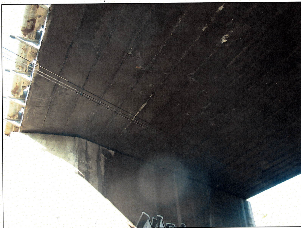
Rys. 4.4. Widok na spód konstrukcji
