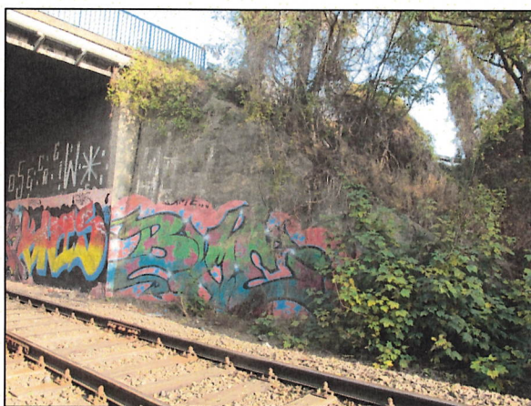
Rys. 5.17. Skrzydło przyczółka od strony Brochów/ Kobierzyce – przenieśczenie murku oporowego na zakończeniu skrzydła oraz duże drzewa porastające na skarpie w bezpośredniej bliskości skrzydła
