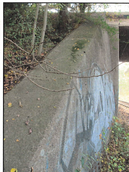
Rys. 5.15. Skrzydło przyczółka od strony Brochów/Wrocław Centralny – przesunięcie murku oporowego na zakończeniu skrzydła oraz duże drzewa porastające na skarpie w bezpośredniej bliskości skrzydła
