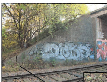
Rys. 5.15. Skrzydło przyczółka od strony Brochów/Wrocław Centralny – przesunięcie murku oporowego na zakończeniu skrzydła oraz duże drzewa porastające na skarpie w bezpośredniej bliskości skrzydła
