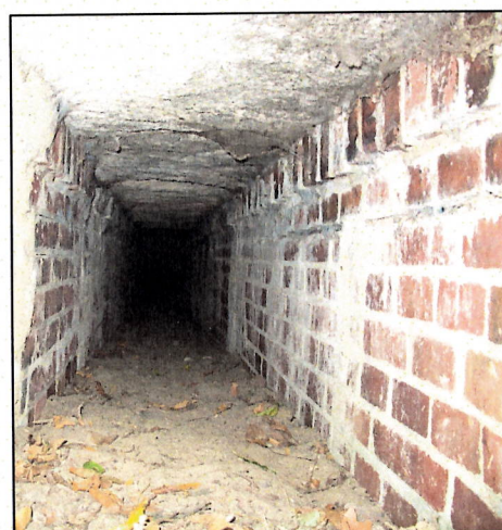
Rys. 5.22 Wloty do przepustu biegnącego wzdłuż przyczółka od strony Brochowa oraz widok wewnątrz przepustu
