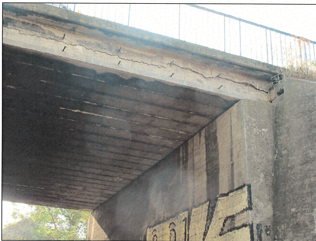
Rys. 4.4. Widok na spód konstrukcji
