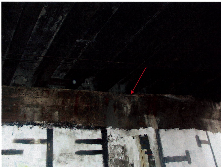
Rys. 5.7. Ubytki betonu do 15 cm, korozja odsłoniętego zbrojenia, wykwyty rdzawe na ławie podłożyskowej – podpora P1 między belkami B3 ÷ B5
