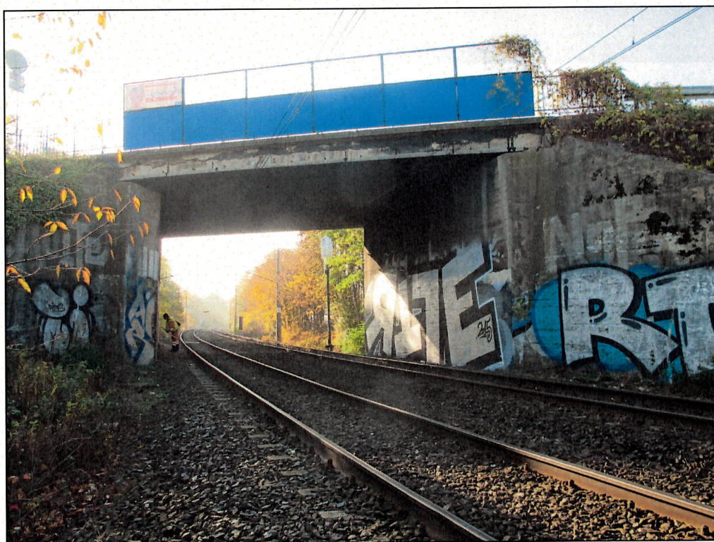
Rys. 4.1. Widok z boku od strony stacji Wrocław Główny
