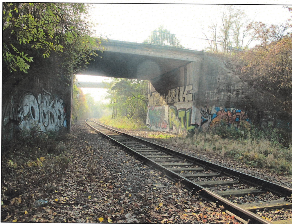
Rys. 4.2. Widok z boku od strony stacji Wrocław Główny
