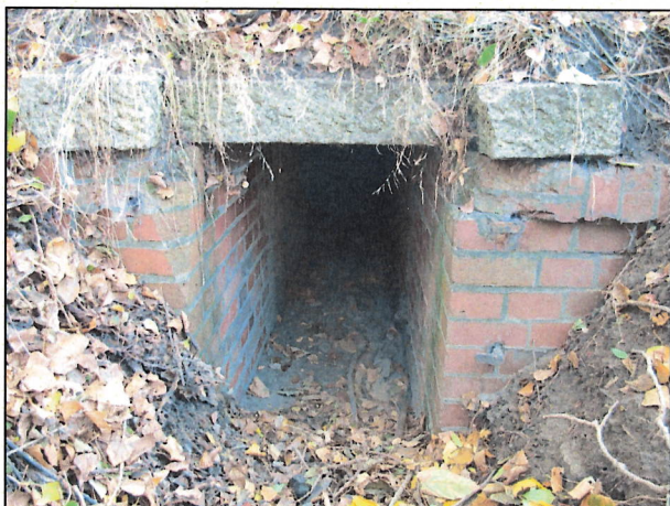
Rys. 5.18 Wloty do przepustu biegnącego wzdłuż przyczółka od strony Brochowa oraz widok wnętrza przepustu
