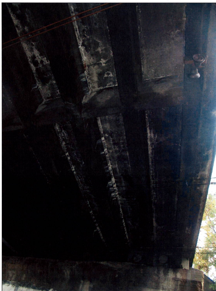
Rys. 4.4. Widok na spód konstrukcji
