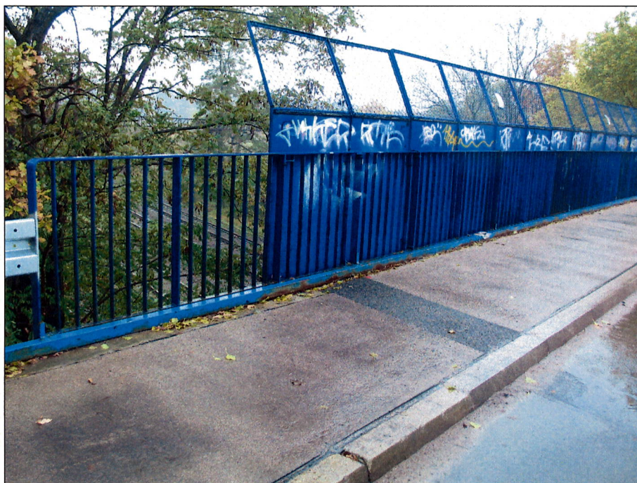
Rys. 5.14. Liczne graffiti na barierze przeciwporażeniowej oraz korozja powierzchniowa profilu stalowego biegnącego wzdłuż balustrady
