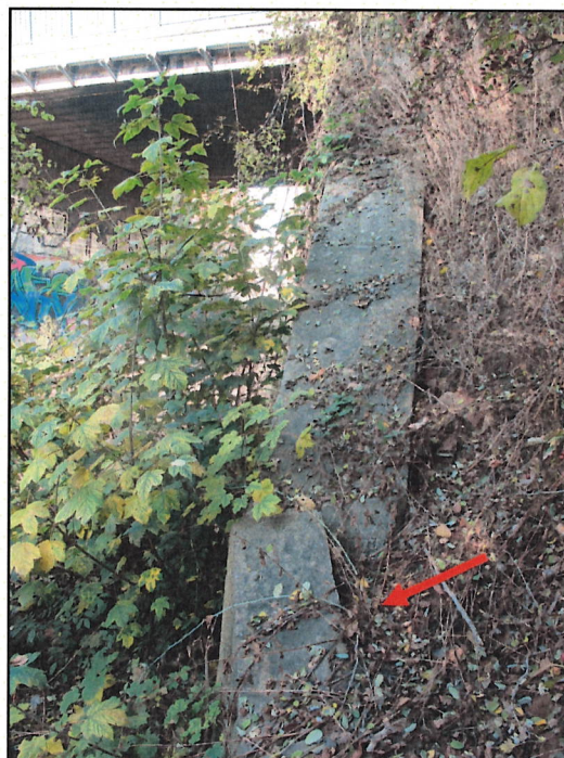
Rys. 5.17. Skrzydło przyczółka od strony Brochów/ Kobierzyce – przenieśczenie murku oporowego na zakończeniu skrzydła oraz duże drzewa porastające na skarpie w bezpośredniej bliskości skrzydła
