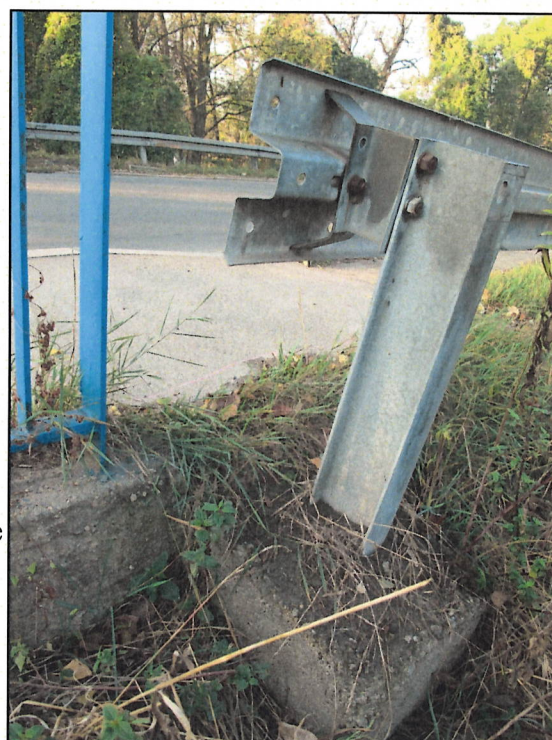
Rys. 5.19. Dojście od strony Centrum/Wrocław Główny – wychylenie skrajnego słupka bariery energochłonnej na zewnątrz obiektu
