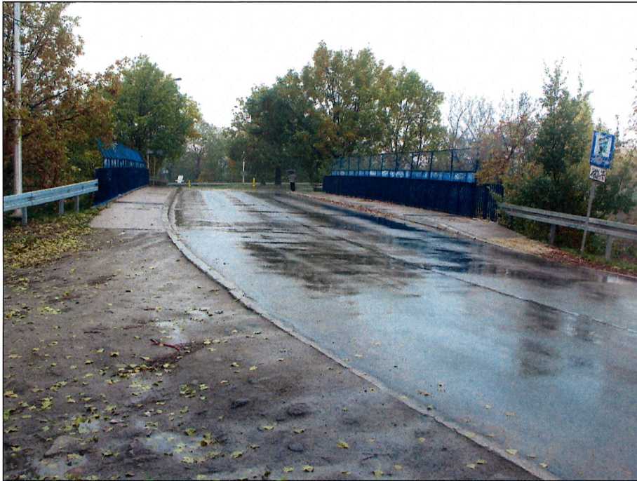
Rys. 5.16. Nawierzchnia jezdni na obiekcie oraz dojazd do obiektu od strony Centrum.
