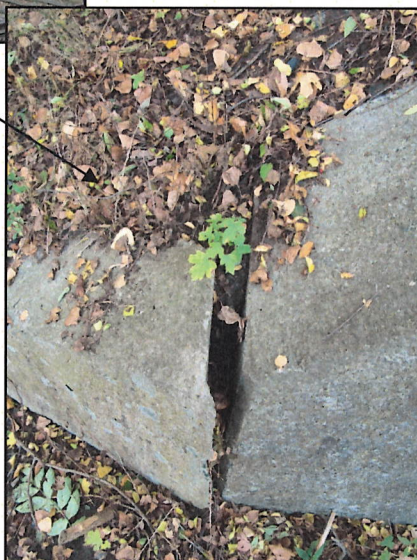
Rys. 5.15. Skrzydło przyczółka od strony Brochów/Wrocław Centralny – przesunięcie murku oporowego na zakończeniu skrzydła oraz duże drzewa porastające na skarpie w bezpośredniej bliskości skrzydła
