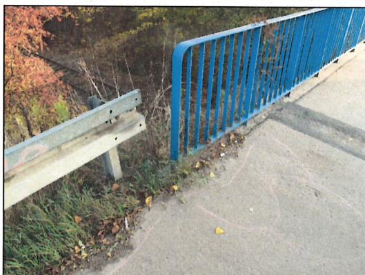
Rys. 5.19. Dojście od strony Centrum/Wrocław Główny – wychylenie skrajnego słupka bariery energochłonnej na zewnątrz obiektu
