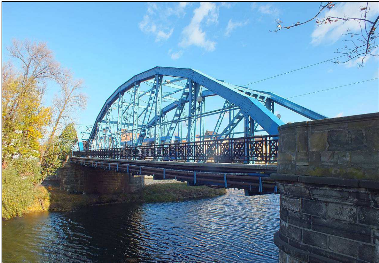
Rys. 4.7 Widok ogólny na obiekt od strony wody dolnej
