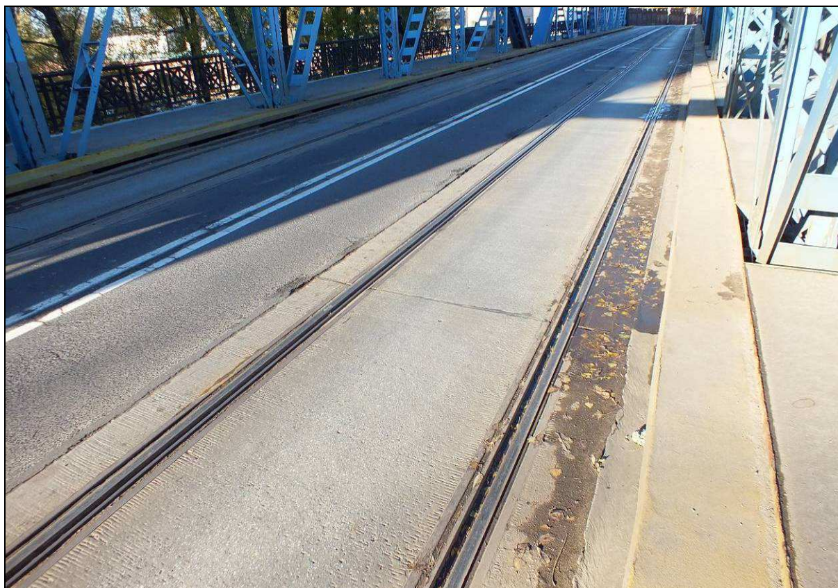
Rys. 4.13 Widok ogólny na nawierzchnię jezdni na obiekcie
