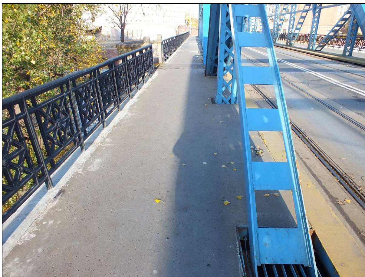
Rys. 4.14 Widok ogólny na nawierzchnię chodnika na obiekcie
