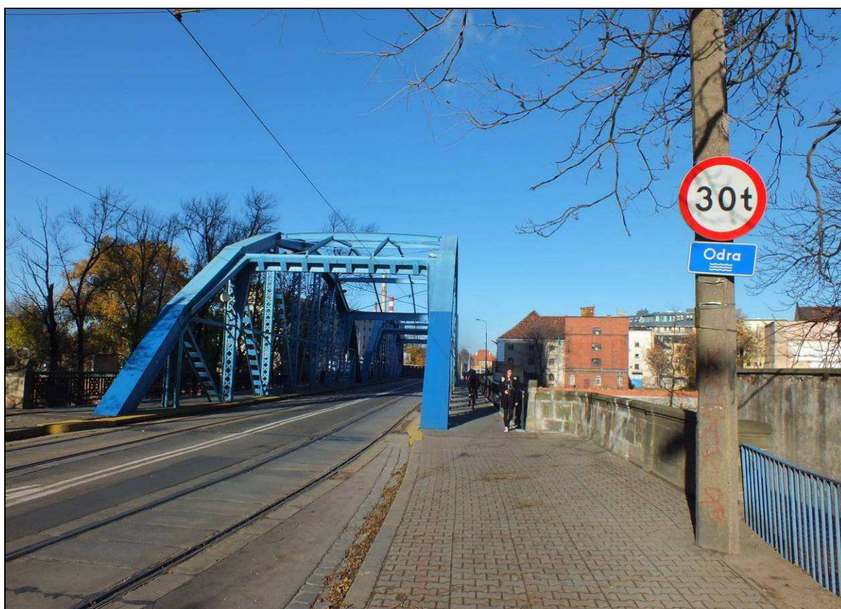
Rys. 4.4 Widok ogólny na obiekt od strony ul. Podwale
