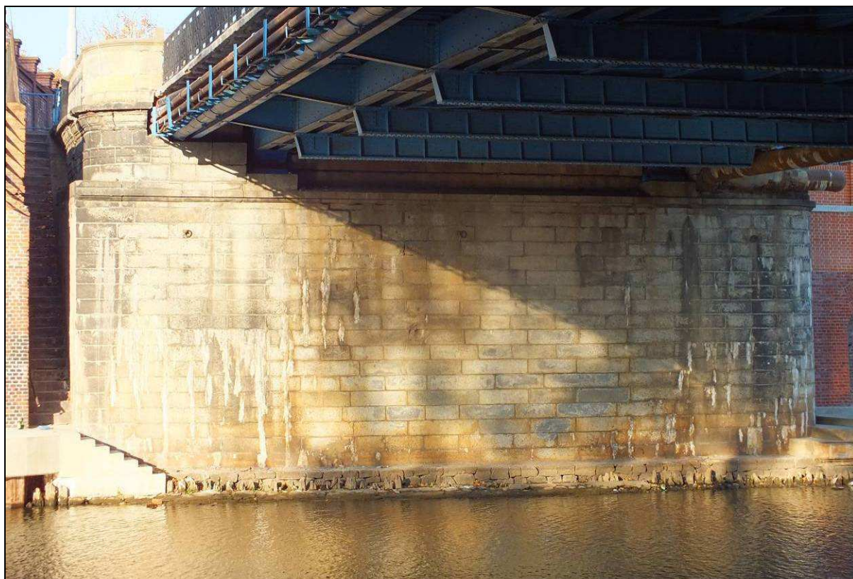
Rys. 4.11 Widok ogólny na przyczółek od strony ul. Mostowej
