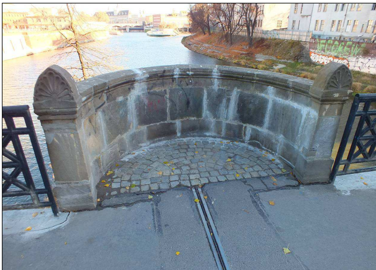
Rys. 4.16 Widok ogólny na kamienną balustradę na obiekcie nad filarem od strony WG
