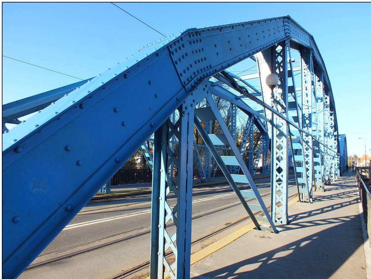
Rys. 4.9 Widok ogólny na kratownicowy dźwigar główny od strony wody górnej przęsła od strony ul. Podwale
