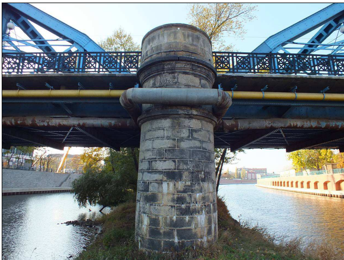
Rys. 4.12 Widok ogólny na filar od strony wody górnej
