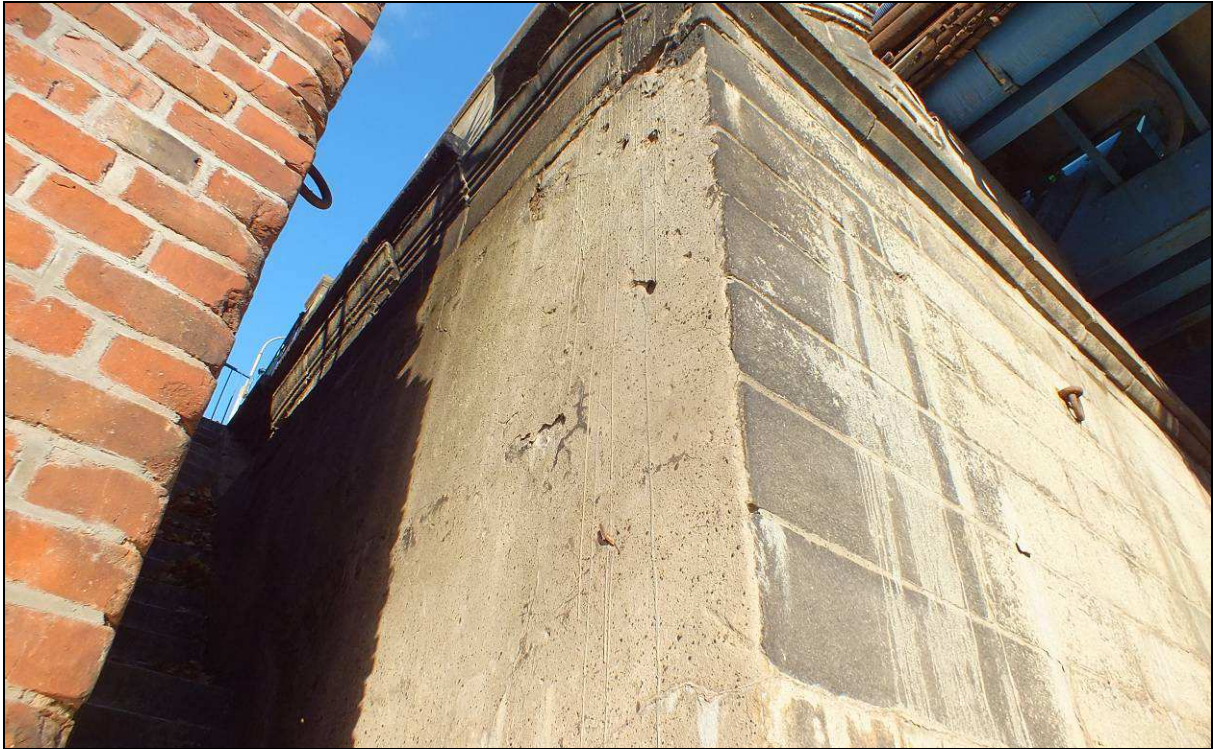
Rys. 5.77 Na zdjęciu powyżej widoczne osłonięcie warstwą betonu skrzydła przyczółka od strony ul. Mostowej od strony wody dolnej, beton utrudnia inspekcję powierzchni okładziny kamiennej przyczółka
