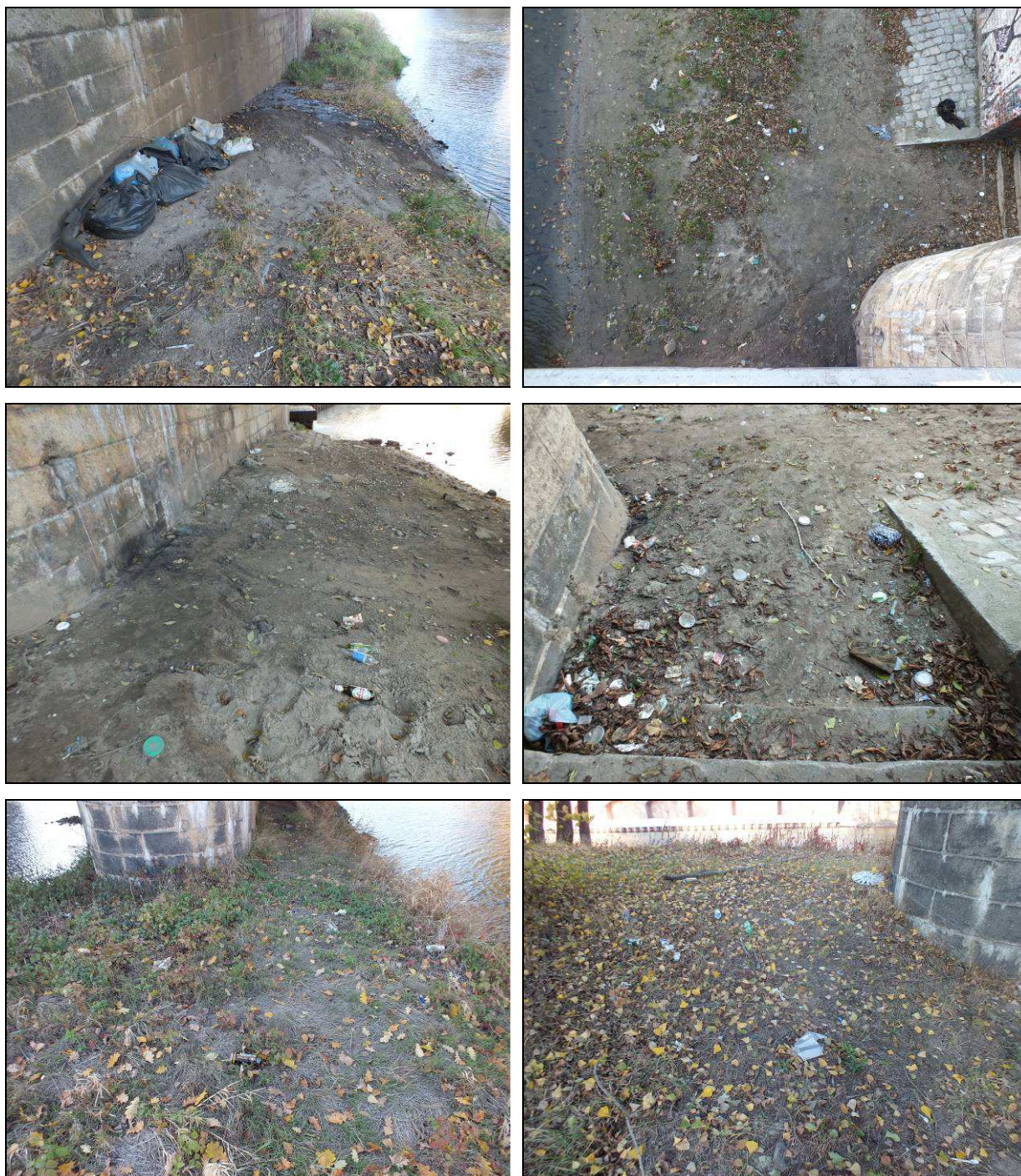
Rys. 5.172 Na zdjęciach powyżej widoczne liczne przykłady zanieczyszczeń odpadami komunalnymi terenu pod obiektem, zanieczyszczenia występują głównie w obrębie podpór
