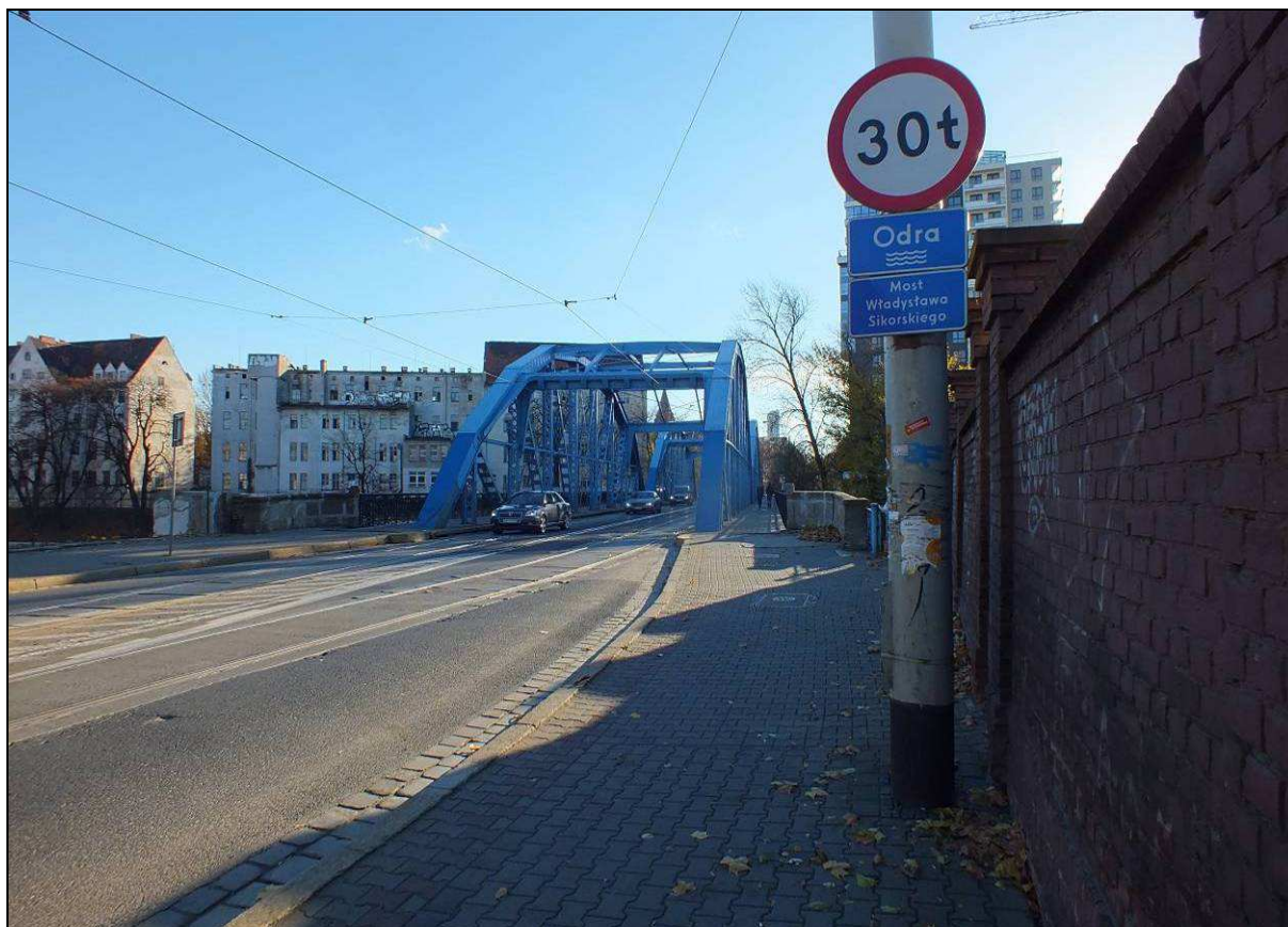
Rys. 4.5 Widok ogólny na obiekt od strony ul. Mostowej
