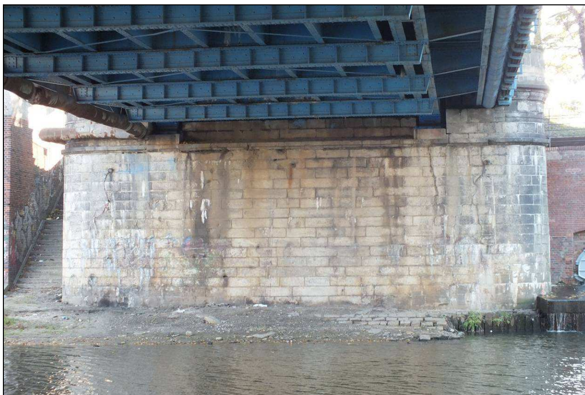
Rys. 4.10 Widok ogólny na przyczółek od strony ul. Podwale
