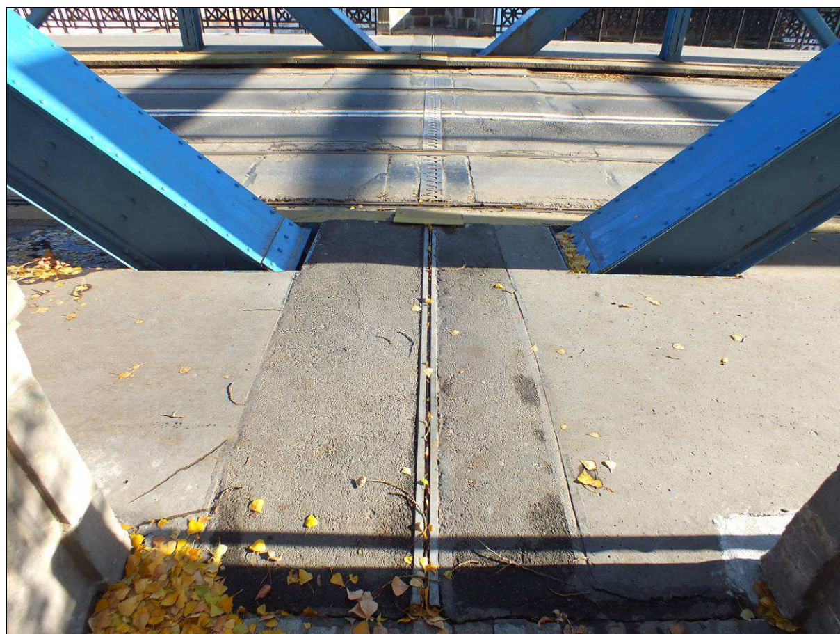
Rys. 4.18 Widok ogólny na urządzenie dylatacyjne nad filarem
