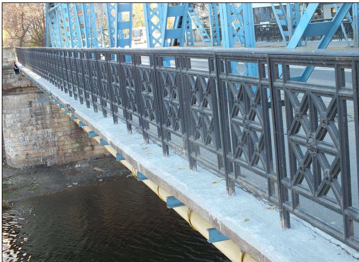
Rys. 4.15 Widok ogólny na stalową balustradę na obiekcie od strony wody górnej
