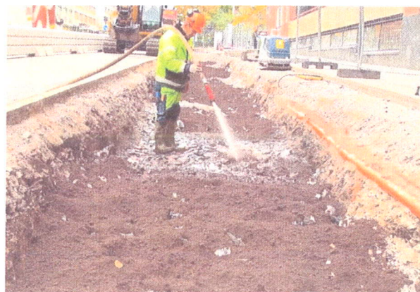
W przestrzenie pomiędzy kamieniami wmywana jest gliniasta ziemia urodzajna, zawierająca 3-4% humusu i rozłożonej próchnicy
