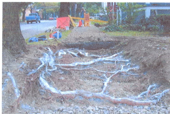
Odsłonięta strefa korzeni
