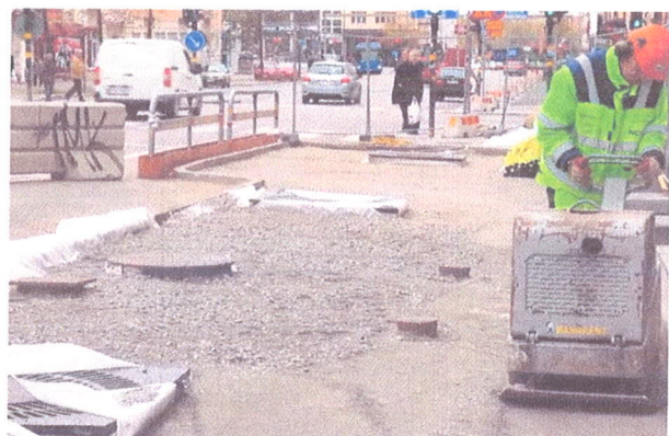
Rozścielenie geotkaniny separacyjnej
