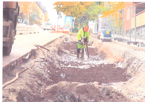
Wpłukiwanie kolejnej warstwy ziemi urodzajnej
