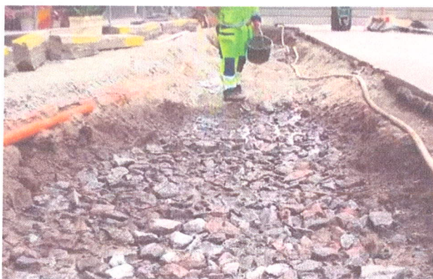
Na warstwie kruszywa należy rozścielić warstwę gliniastej ziemi urodzajnej wraz z humusem i próchnicą
