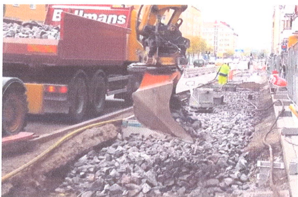
Rozkładanie kolejnej warstwy kruszywa łamanego 63/100
