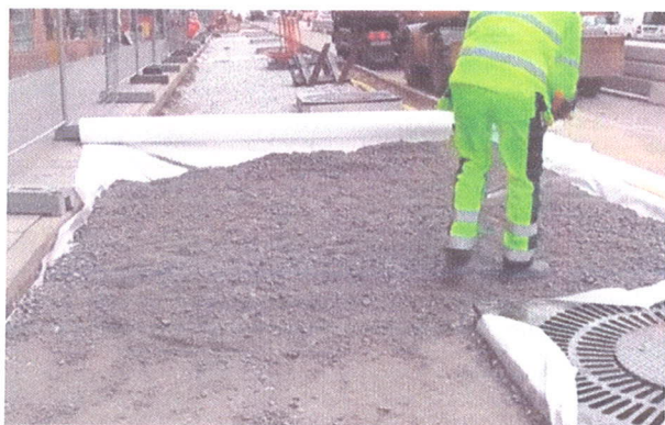
Górna warstwa kruszywa w podłożu strukturalnym
