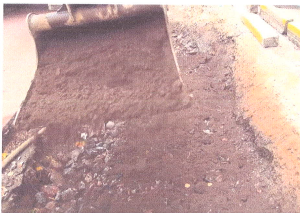
Na warstwie kruszywa należy rozścielić warstwę gliniastej ziemi urodzajnej wraz z humusem i próchnicą
