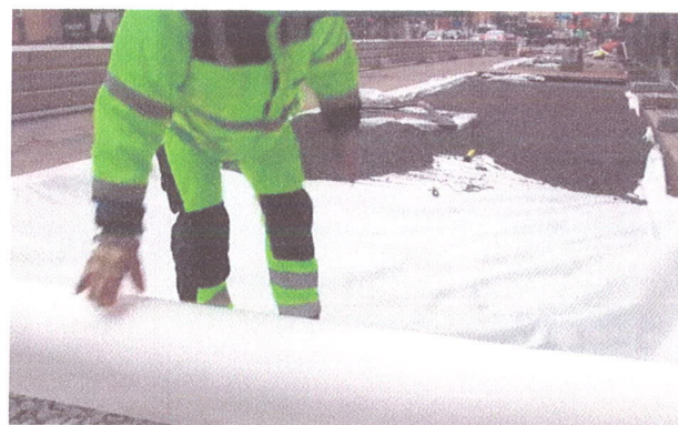
Rozścielenie geotkaniny separacyjnej
