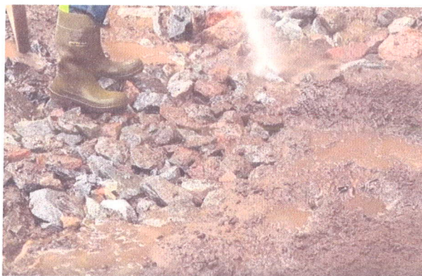
Wpłukiwanie kolejnej warstwy ziemi urodzajnej
