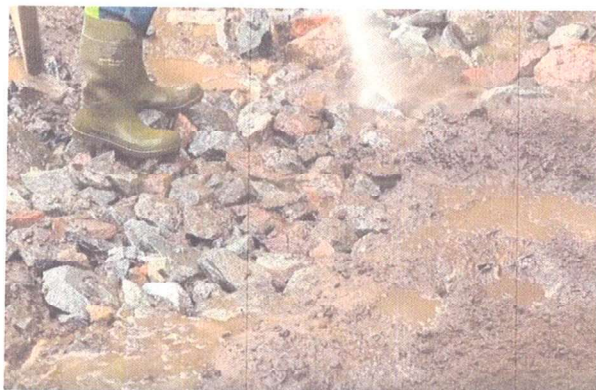
Wpłukiwanie kolejnej warstwy ziemi urodzajnej
