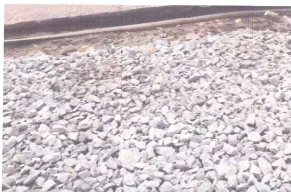
Górna warstwa kruszywa w podłożu strukturalnym
