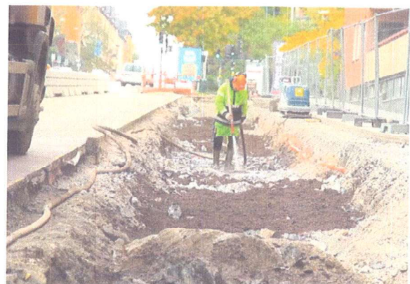
Wpłukiwanie kolejnej warstwy ziemi urodzajnej
