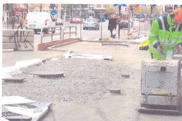
Rozścielenie geotkaniny separacyjnej
