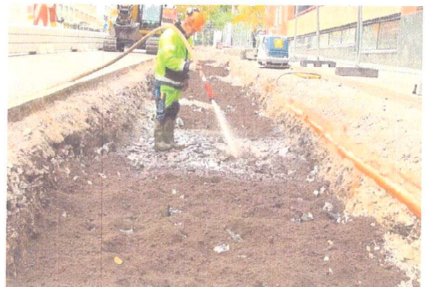
W przestrzeni pomiędzy kamieniami wmywana jest gliniasta ziemia urodzajna, zawierająca 3-4% humusu i rozłożonej próchnicy
