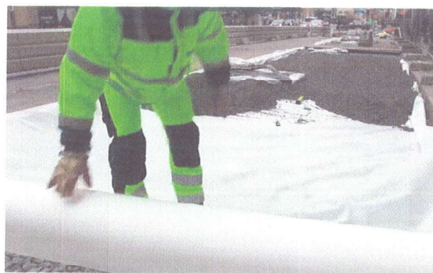
Rozścielenie geotkaniny separacyjnej
