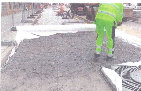
Górna warstwa kruszywa w podłożu strukturalnym
