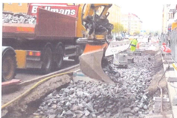
Rozkładanie kolejnej warstwy kruszywa łamanego 63/100
