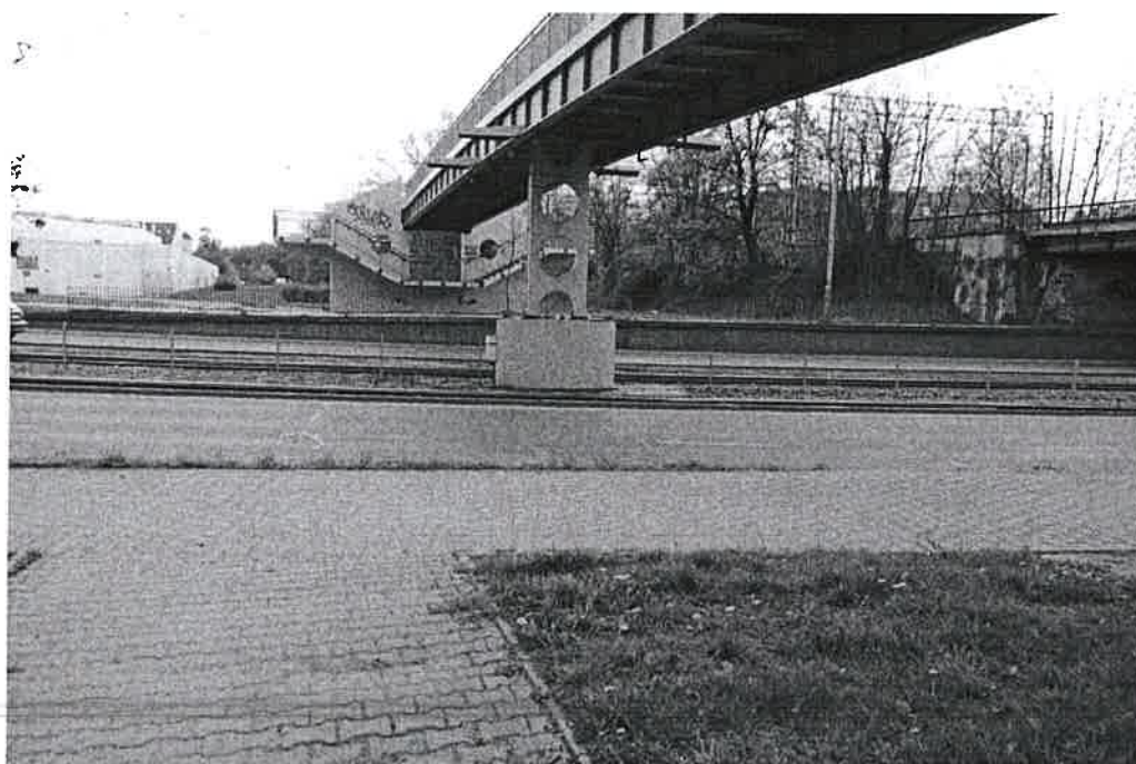
Fot. 10. Widok ogólny przestrzeni pod obiektowej – jezdni i torowisko tramwajowe.
