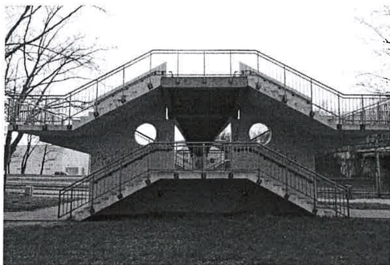
Fot.7. Widok ogólny podpór skrajnych – konstrukcje wsporcze biegów schodowych kładki (po lewej podpora południowa, po prawej podpora północna).
