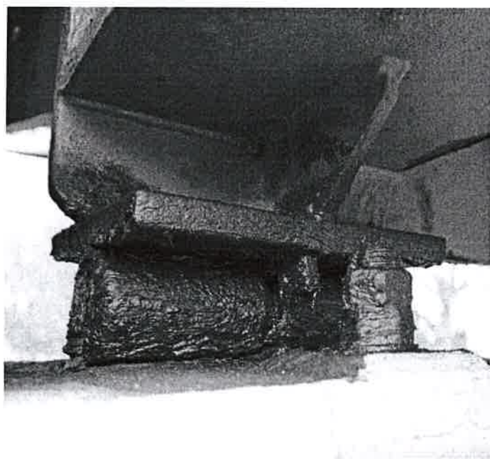
Fot. 6. Widok ogólny łożysk – łożyska stalowe, stałe od strony południowej, przesuwne od strony północnej, filar środkowy wykonany w postaci wahacza.
