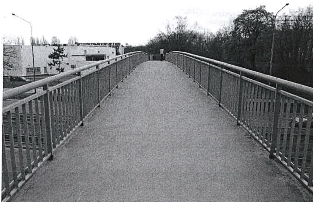
Fot.1. Widok ogólny obiektu wraz z dojściem patrząc od strony północnej.
