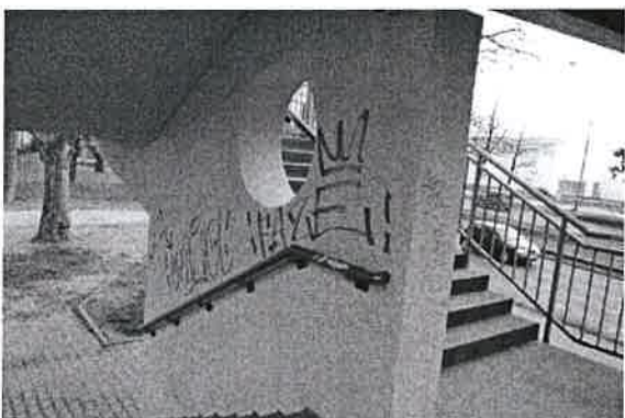
Fot.21. Zanieczyszczenia powłokami graffiti konstrukcji wsporczych biegów schodowych. Zaleca się usunięcie graffiti z powierzchni betonowych przy biegach schodowych.
