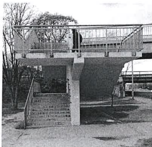
Fot.7. Widok ogólny podpór skrajnych – konstrukcje wsporcze biegów schodowych kładki (po lewej podpora południowa, po prawej podpora północna).
