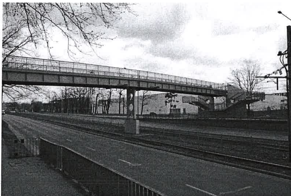
Fot.4. Widok ogólny obiektu patrząc z boku od strony zachodniej.
