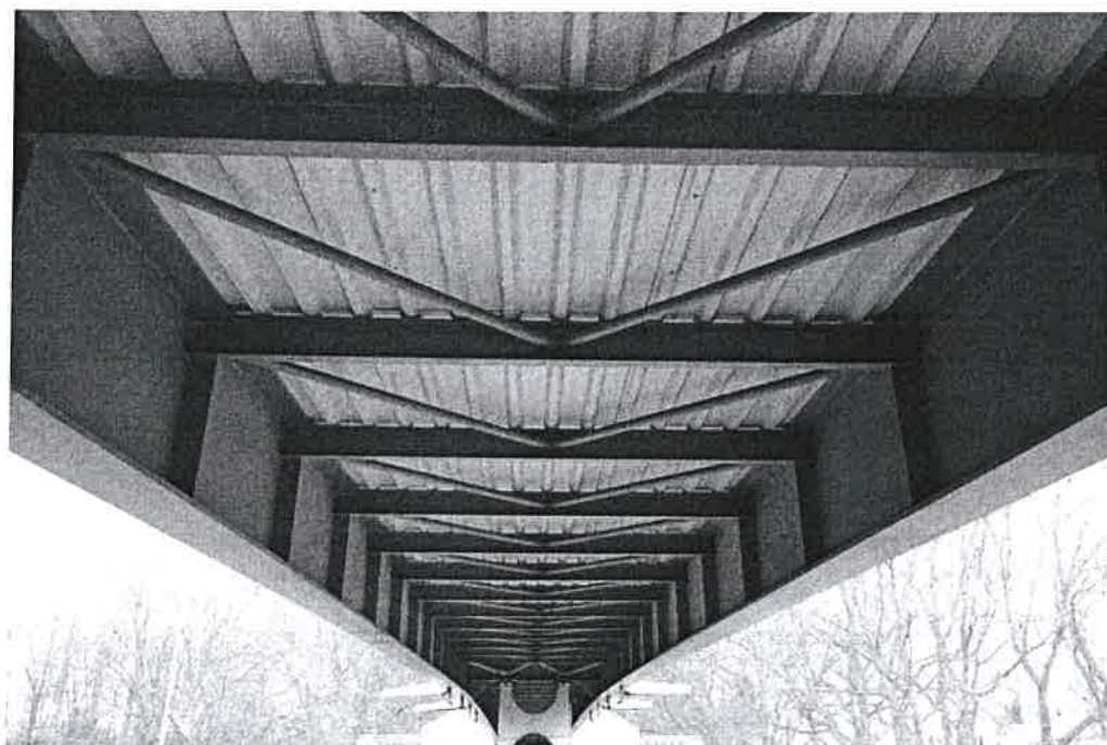
Fot. 5. Widok od spodu konstrukcji nośnej kładki – ruszt stalowy ustroju nośnego.
