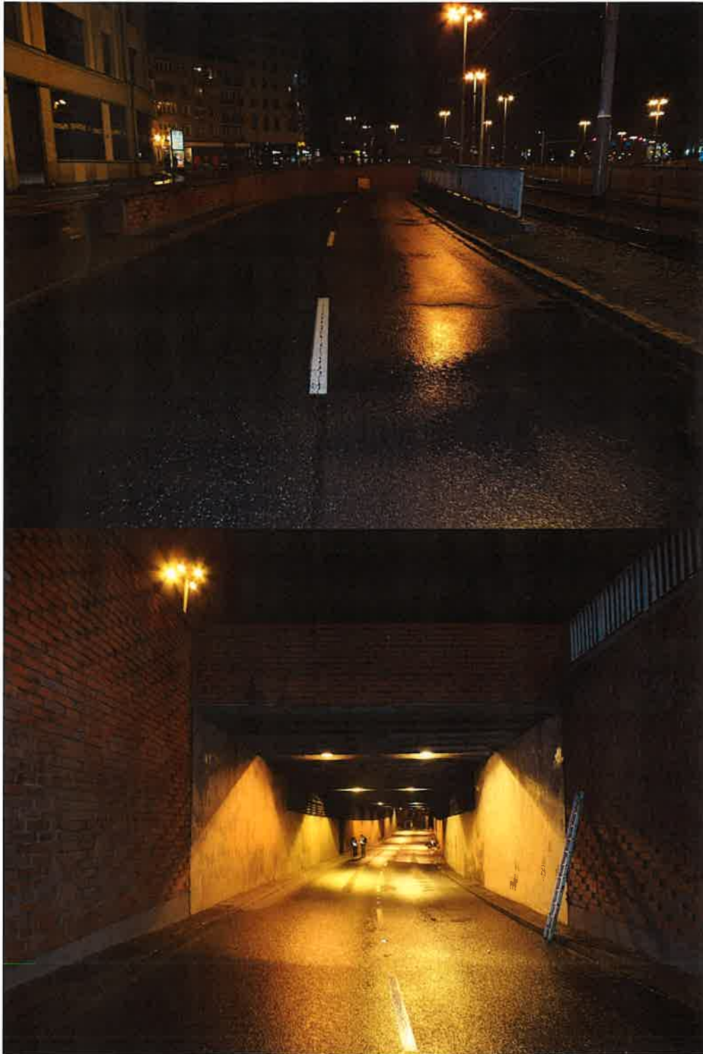
Rysunek 1.2. Widok wyjazdu z tunelu od strony zachodniej
