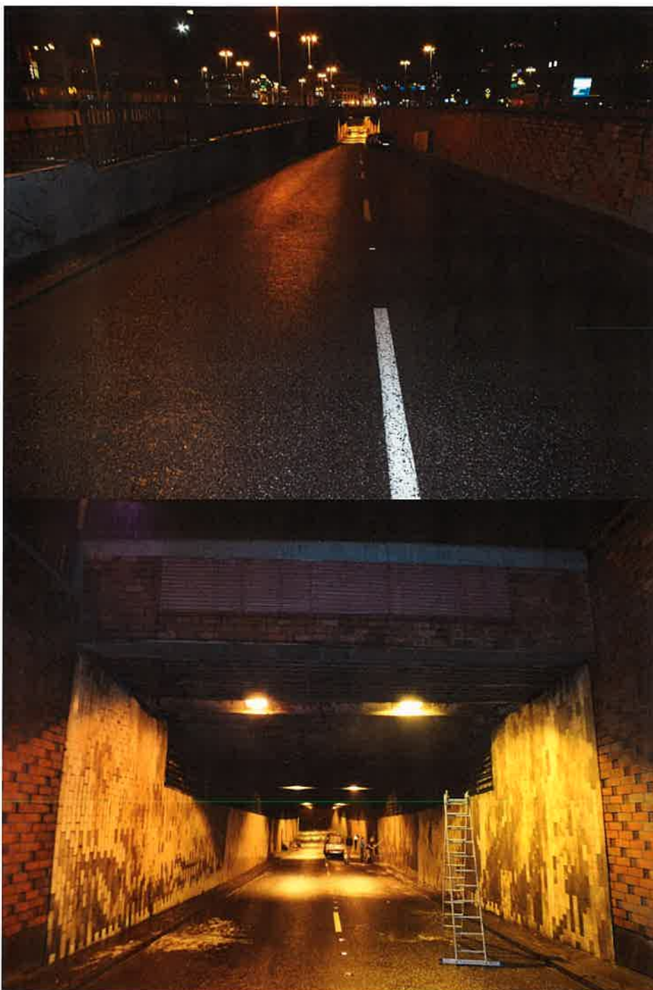
Rysunek 1.1. Widok wjazdu do tunelu od strony wschodniej
