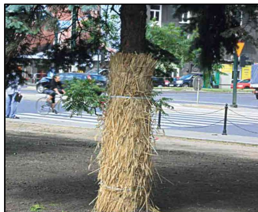
Rys. Przykład poprawnej osłony przypniowej:
