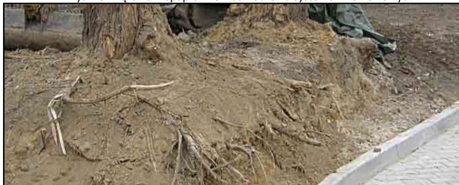
Rys. Efekt złego wykonywania robót budowlanych – odcięcie i odsłonięcie korzeni
