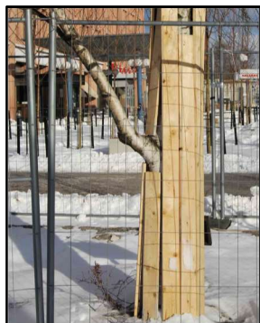
po lewej – za pomocą opon i desek, po prawej – za pomocą skrzyni Rysunek: SPOSOBY ZABEZPIECZENIA DRZEW.
