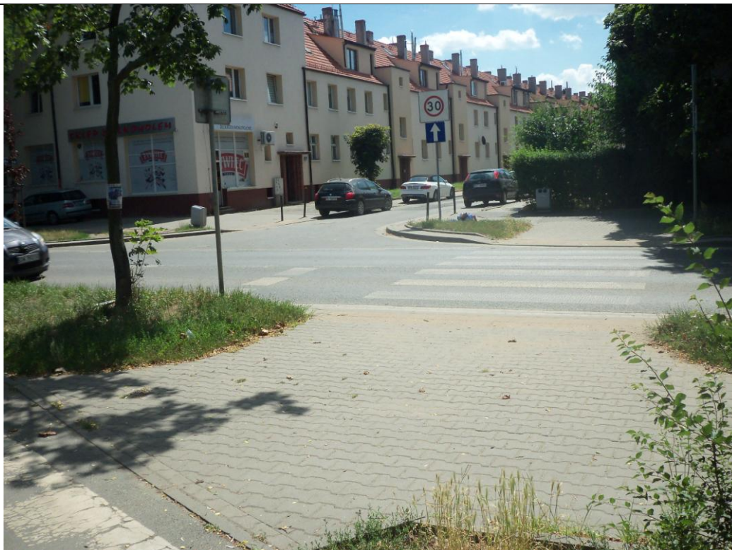
Fot. 4. Istniejąca nawierzchnia po zachodniej stronie przejścia dla pieszych na ul. Kamińskiego
