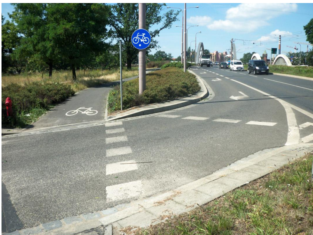
Fot. 1. Widok na istniejącą ścieżkę rowerową równoległą do al. Kromera
