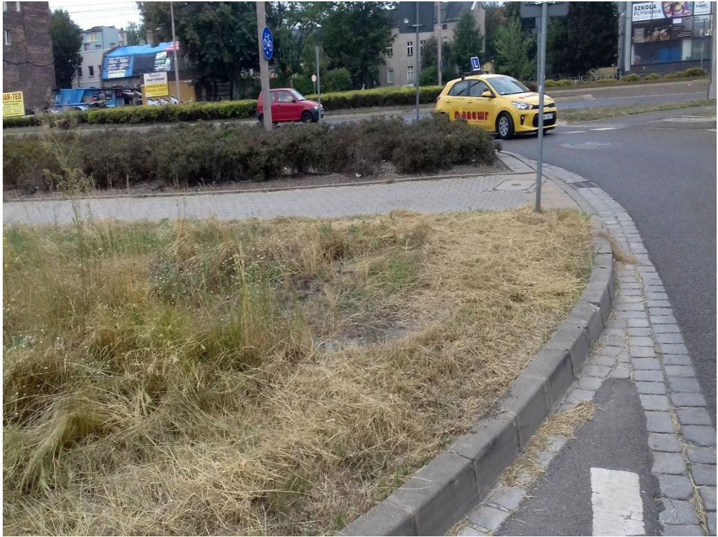
Fot. 2. Początek projektowanej ścieżki rowerowej
