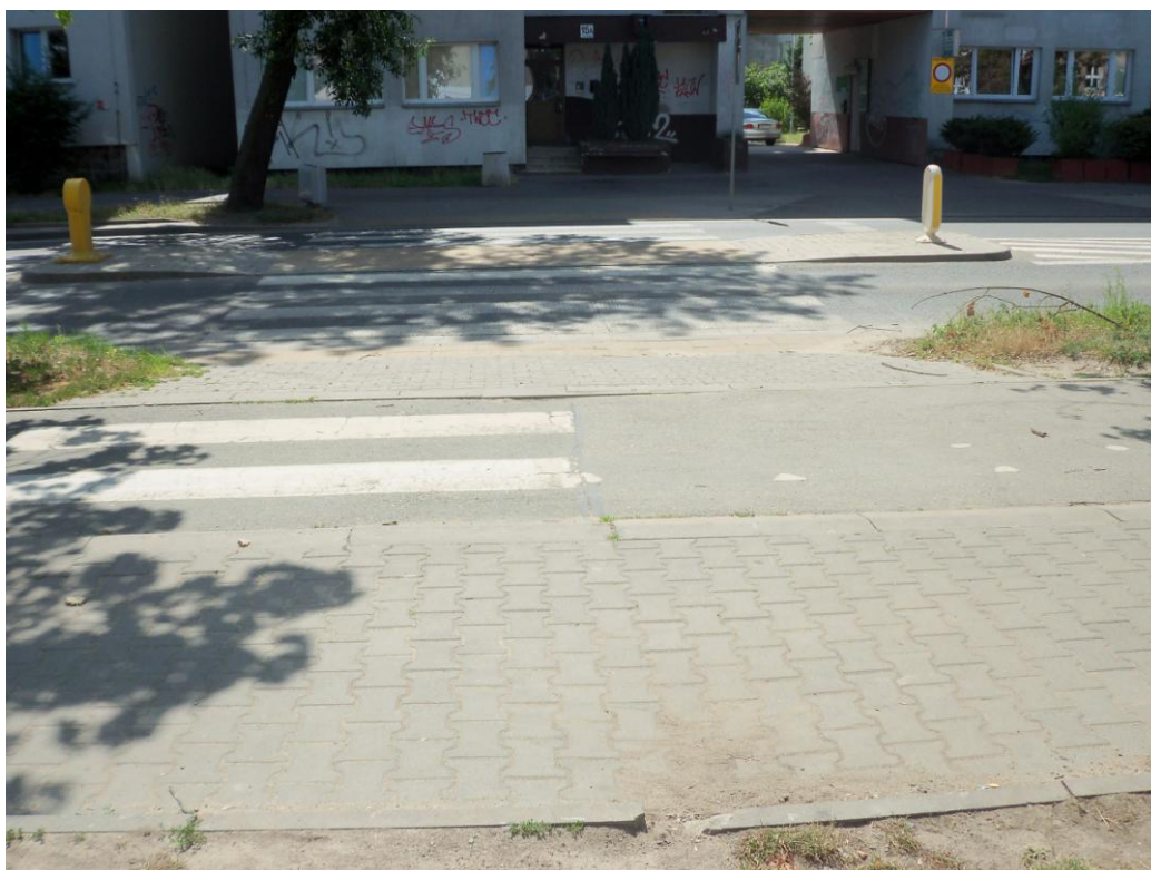
Fot. 1. Istniejąca nawierzchnia w obrębie przejścia dla pieszych od strony północno-zachodniej
