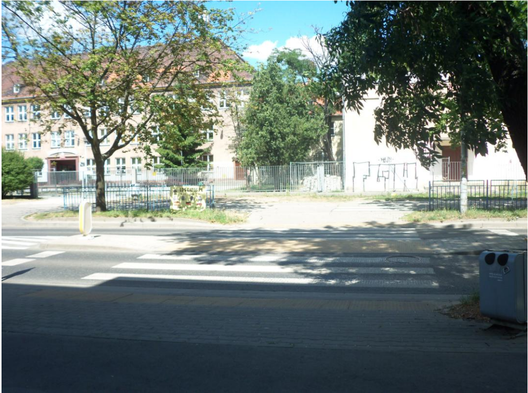
Fot. 2. Istniejąca nawierzchnia w obrębie przejścia dla pieszych od strony południowo-wschodniej
