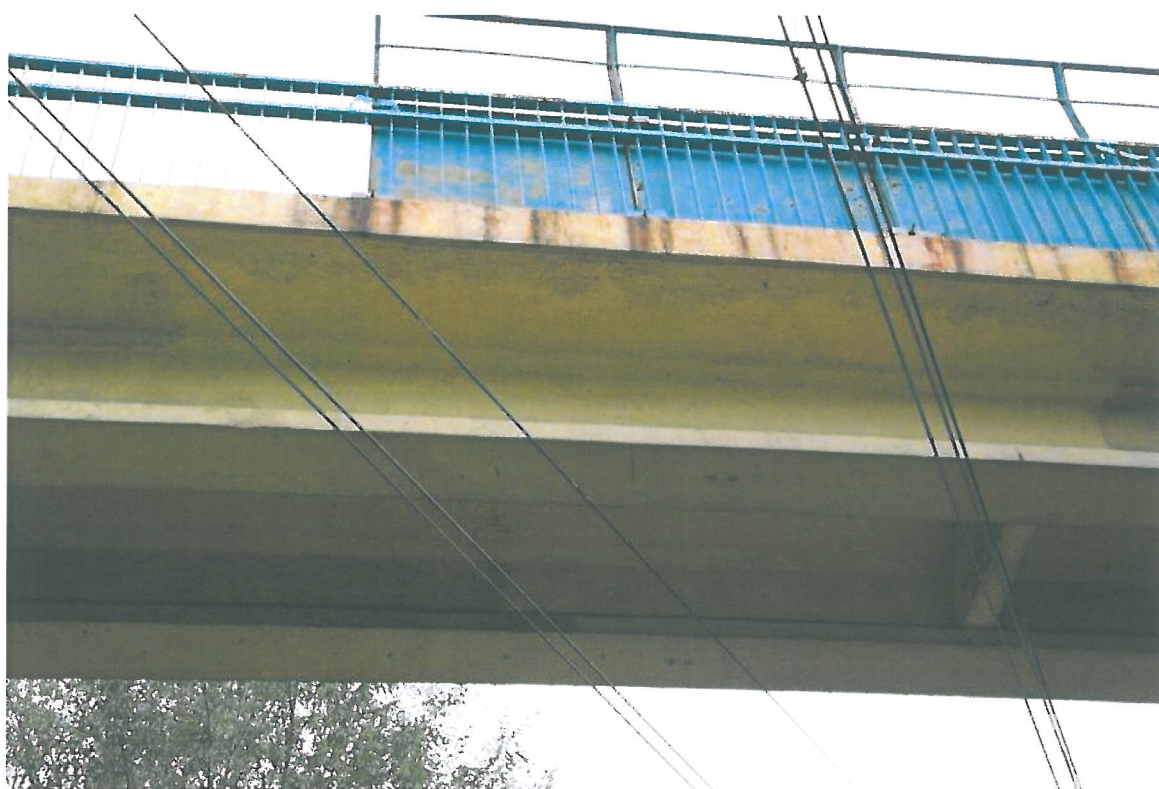
Fot. 8. Widok od spodu na konstrukcję kładki w strefie nad torami PKP.
