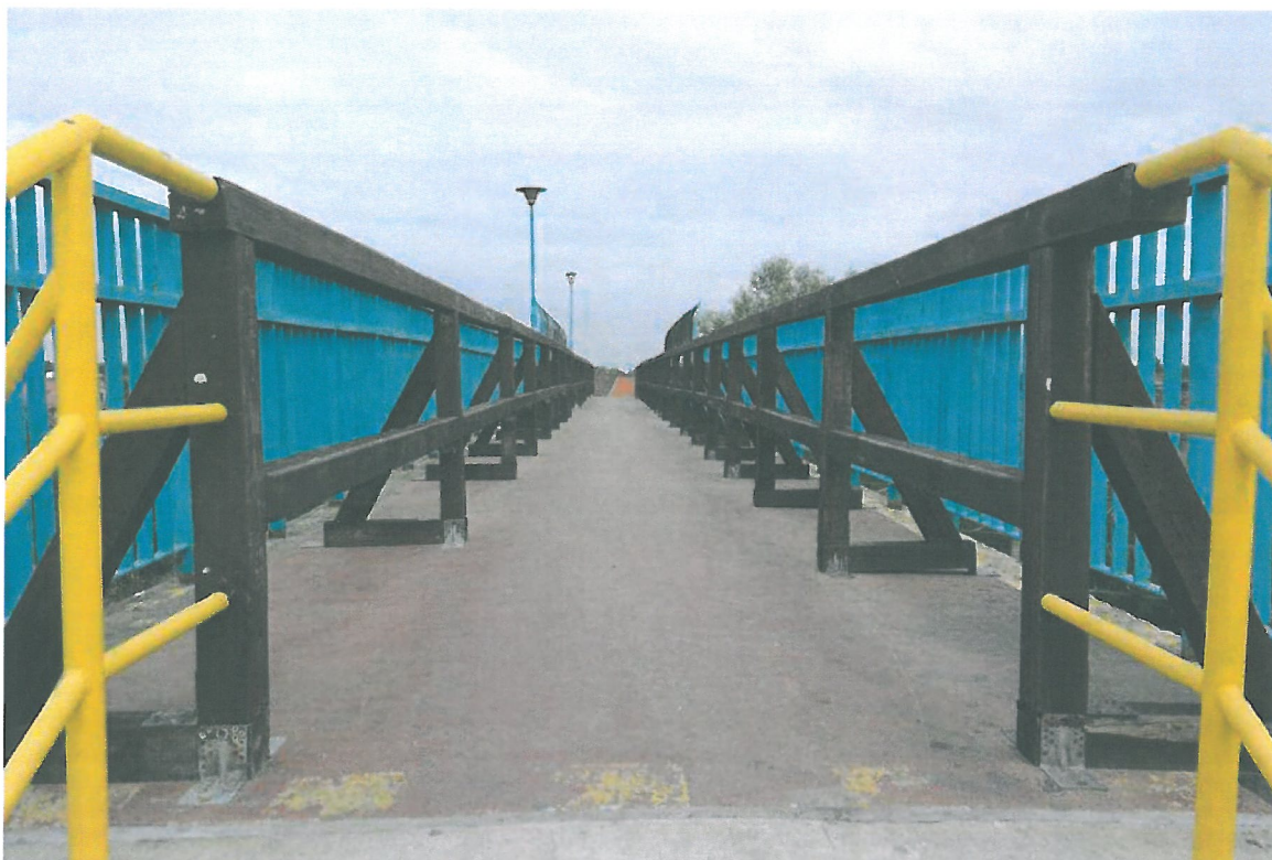
Fot. 5. Widok z góry na kładkę od strony ul. Piwnika Ponurego – pomost nad torami PKP.
