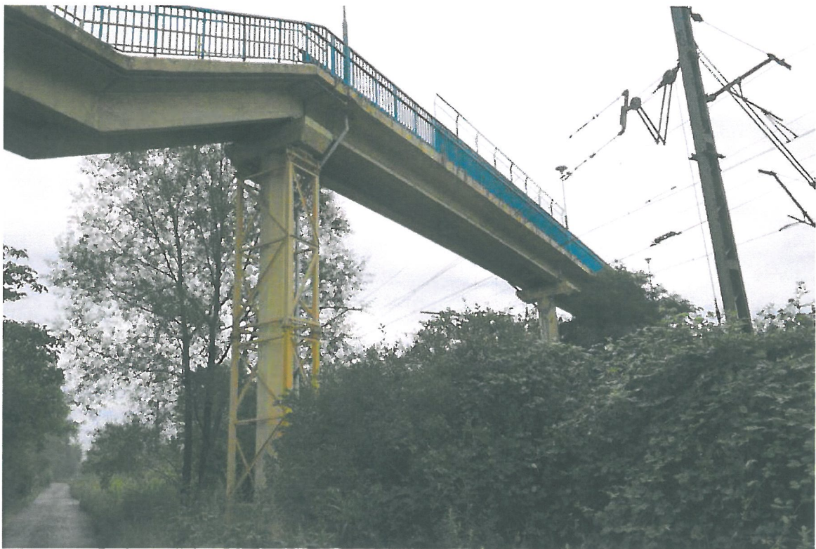
Fot. 43. Podpora nr 7 na styku biegu schodowego od strony ul. Piwnika Ponurego i części poziomej kładki nad terenem kolejowym – widoczne podparcie tymczasowe oczepu.
