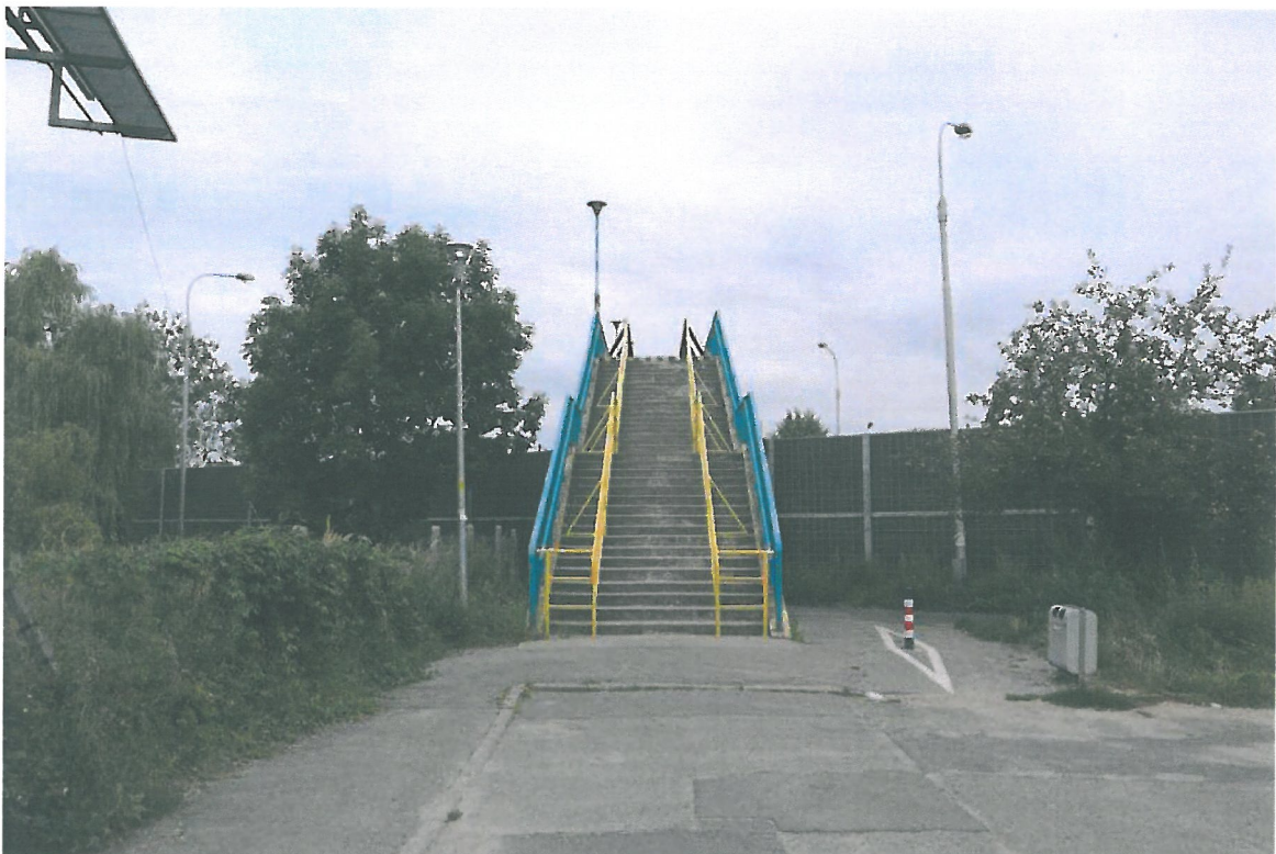
Fot. 2. Widok dojścia do kładki od strony ul. Sycowskiej.
