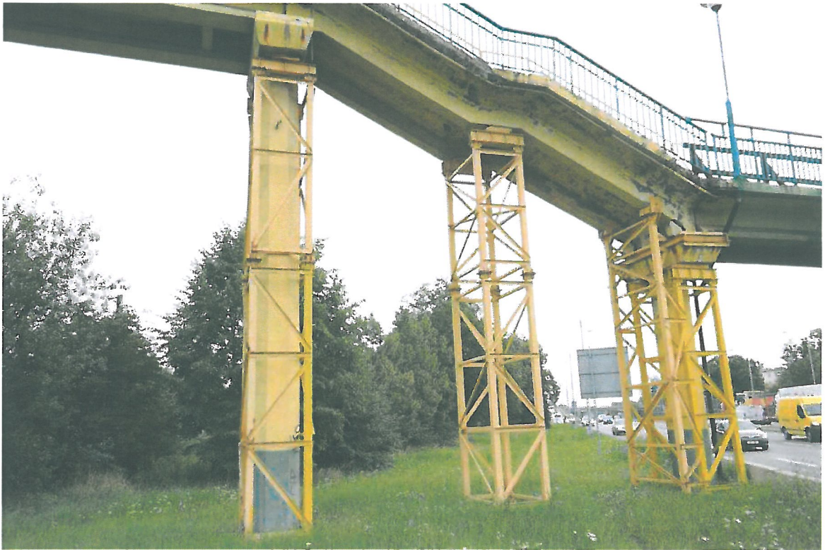
Fot. 37. Tymczasowe podparcie biegu schodowego w postaci podpory z klatek stalowych – podpora zlokalizowana między wzmocnionymi podporami nr 4 (z prawej) i nr 5 (z lewej).
