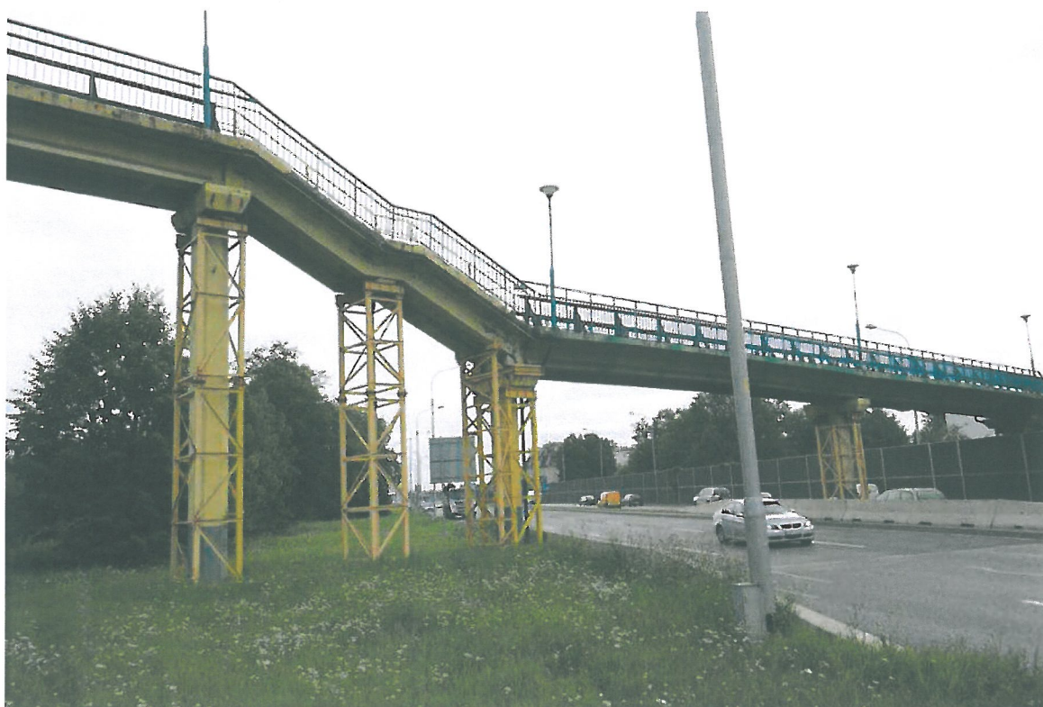
Fot. 3. Widok z boku na kładkę od strony zachodniej (od strony centrum Wrocławia).
