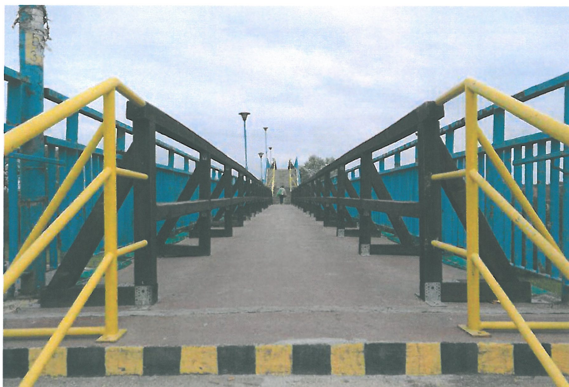
Fot. 6. Widok z góry na kładkę od strony ul. Sycowskiej – pomost nad drogą krajową nr 98.
