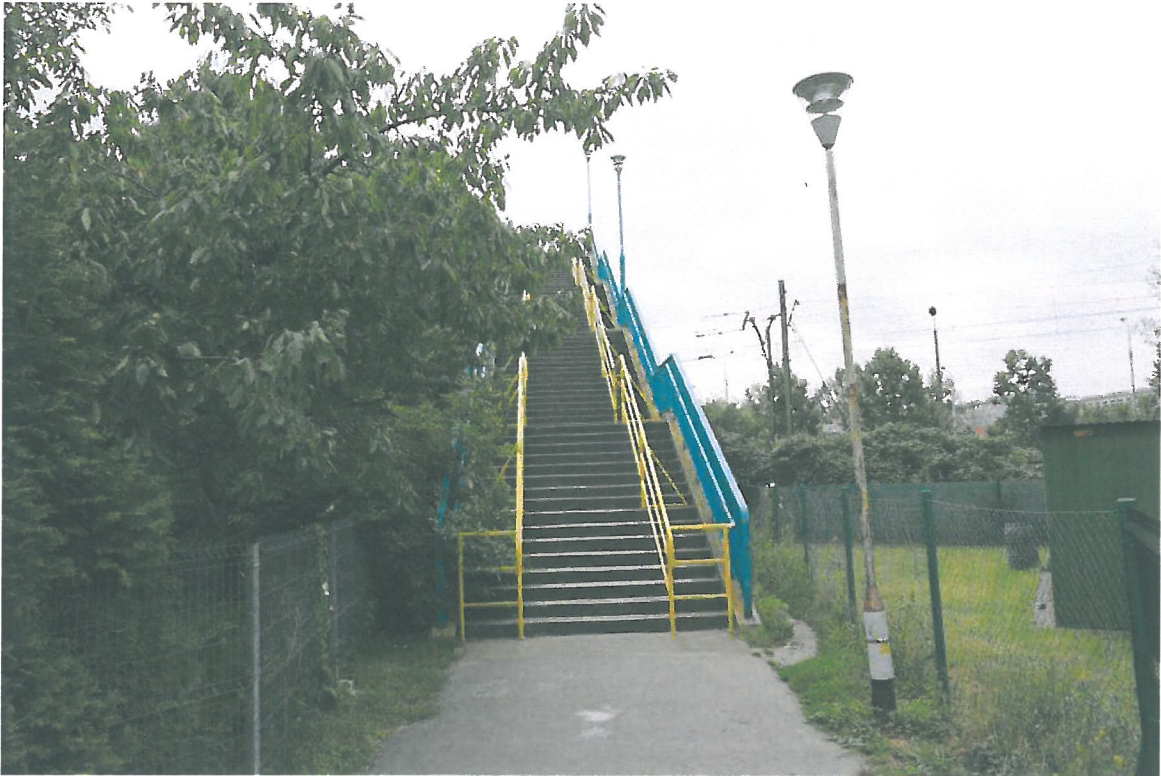
Fot. 1. Widok dojścia do kładki od strony ul. Piwnika Ponurego.
