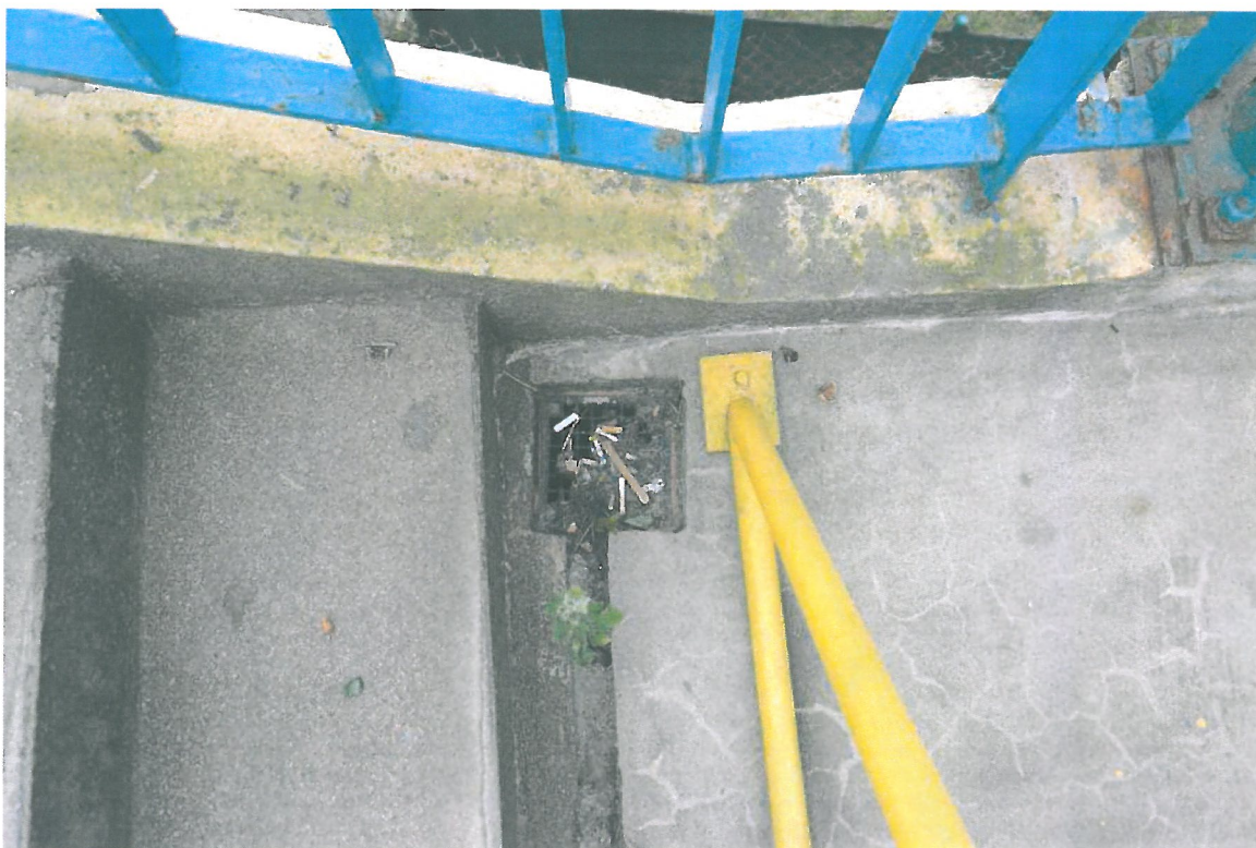
Fot. 25. Zanieczyszczone, niedrożne wpusty odwadniające, uszkodzenia i braki w nawierzchni żywicznej kładki, odsłaniające spękaną konstrukcją płyty pomostu.
