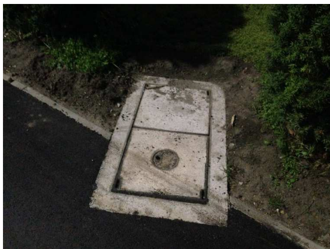
Zdj.1 – Kształtowanie obrzeży ograniczających drogę rowerową na styku z istniejącymi urządzeniami obcymi. Lokalizacja: Rondo Powstańców Śląskich, Wrocław.
