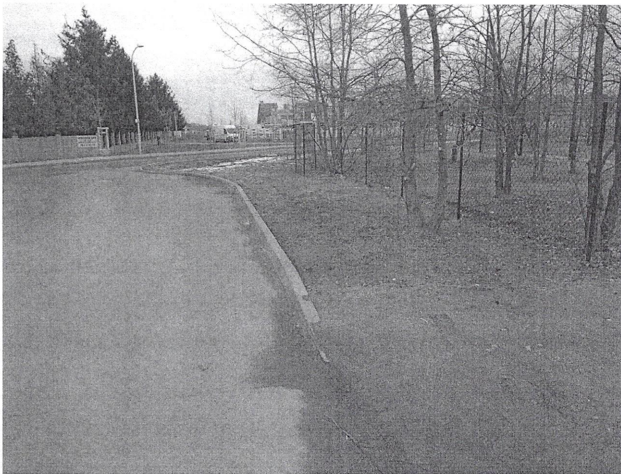
Zdjęcie nr 3– Lokalizacja chodnika w ul. Tymiankowej – widok w kierunku ul. Cynamonowej
