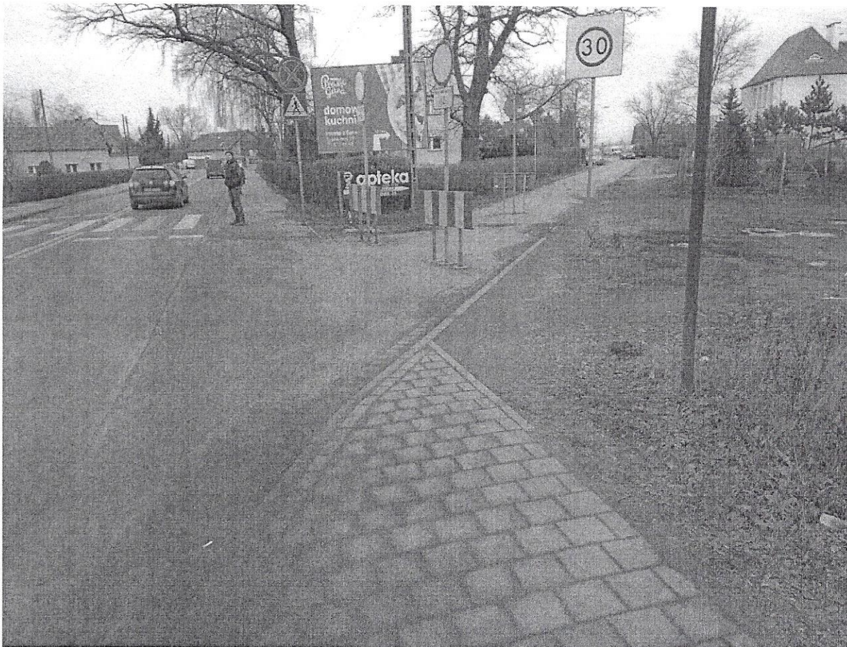
Zdjęcie nr 1 – Miejsce połączenia z chodnikiem w ul. Pełczyńskiej – widok w kierunku ul. Cynamonowej
