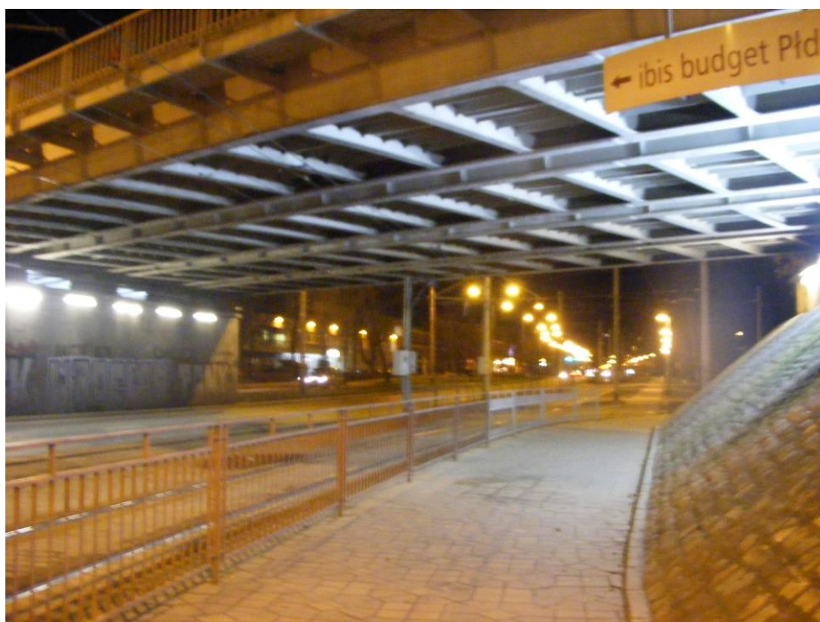
Fot. 1 Widok od strony północnej na skarpę zachodniego przyczółka – stan istniejący
