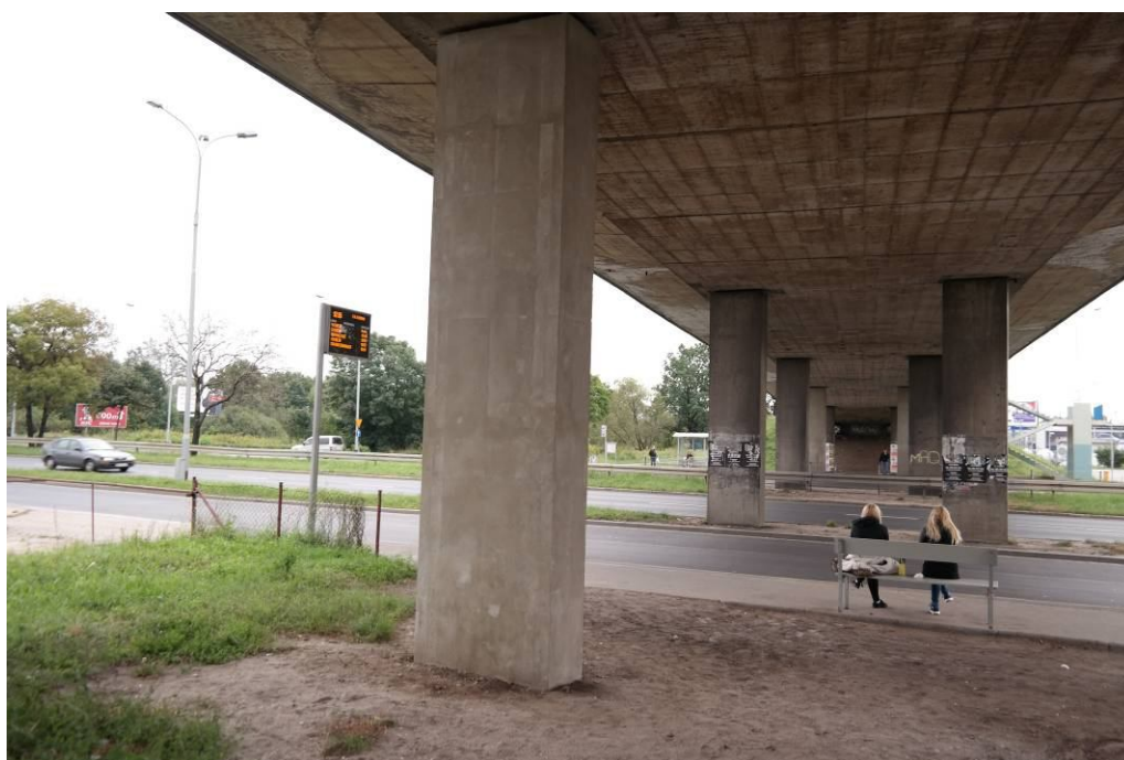
Fot. 5. Przestrzeń podmostowa
