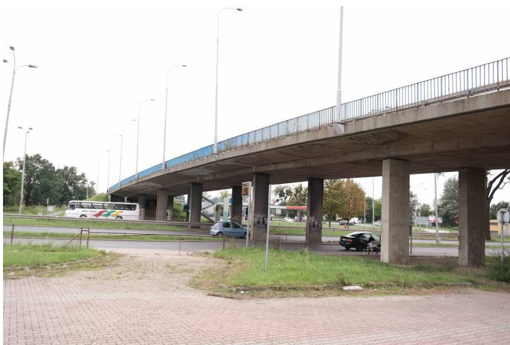
Fot. 1. Widok na wiadukt od strony wschodniej.
