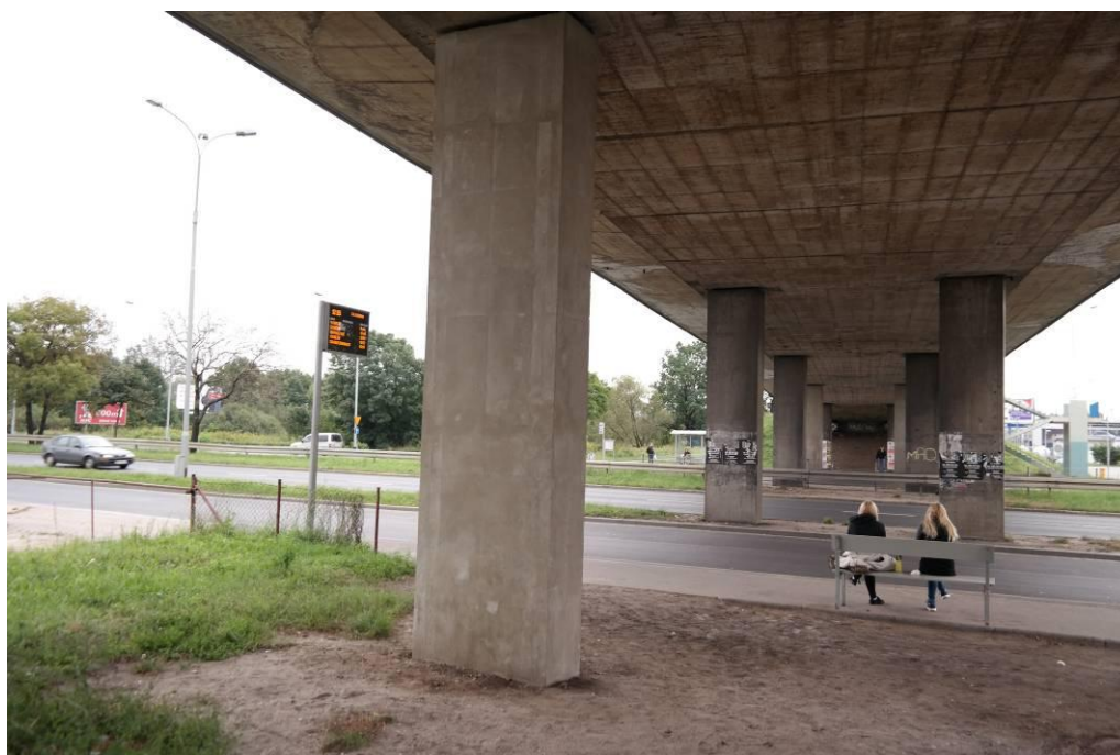
Fot. 5. Przestrzeń podmostowa
