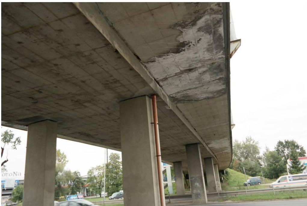
Fot. 3. Widok na filary oraz spód konstrukcji od strony południowej.
