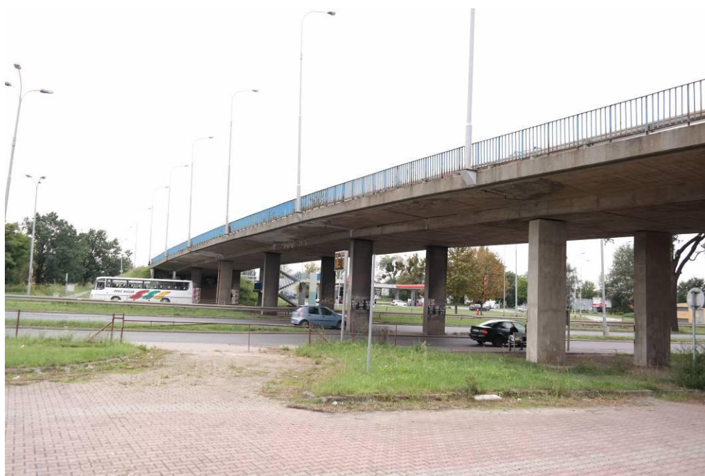
Fot. 1. Widok na wiadukt od strony wschodniej.
