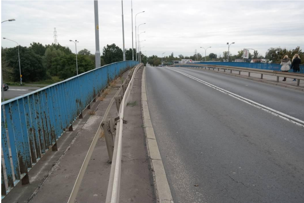
Fot. 2. Widok na pomost obiektu od strony północnej.
