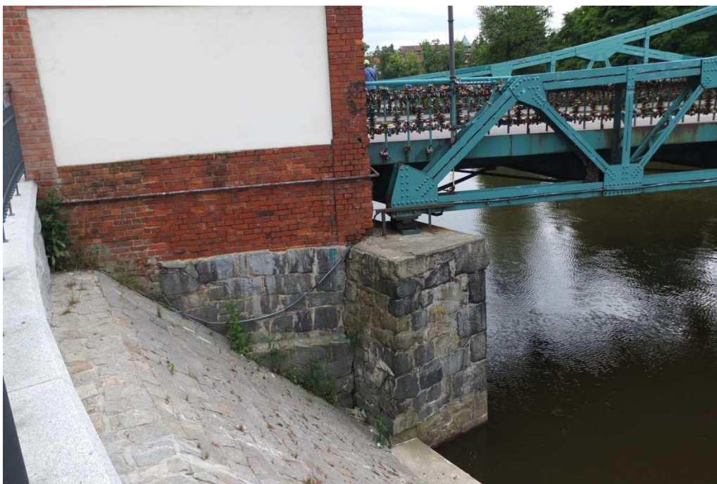
Fot. 21. Zbliżenie na ścianę przyczółka wschodniego.
