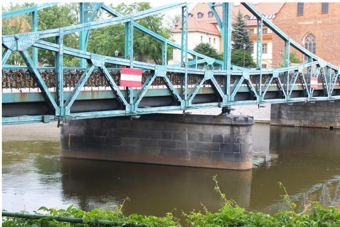
Fot. 15. Widok filara od zachodu.
