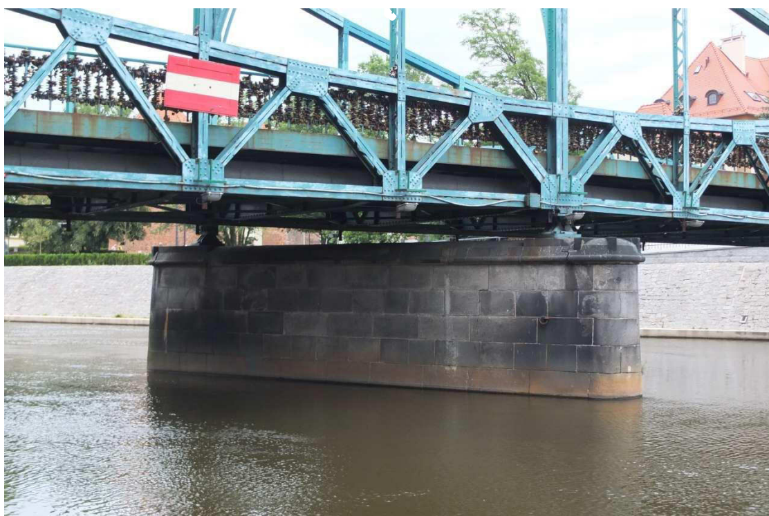
Fot. 16. Widok filara od zachodu w zbliżeniu.
