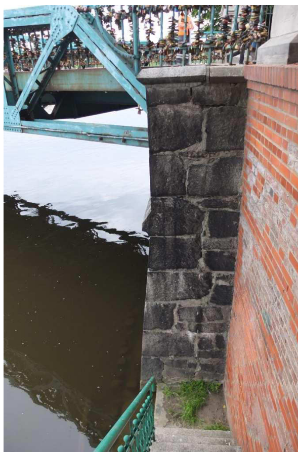
Fot. 22. Zbliżenie na ścianę przyczółka zachodniego od strony dolnej wody.
