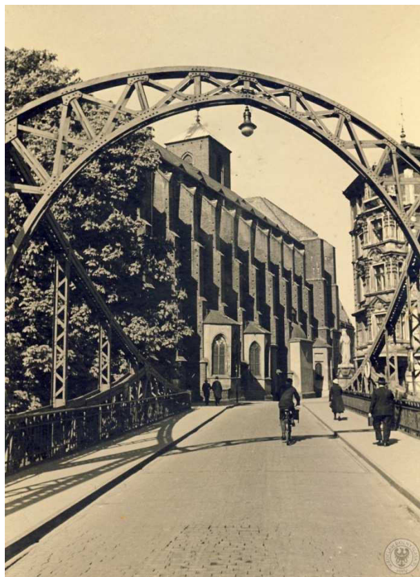
Fot. 6. Zdjęcie mostu z 1936 r.
