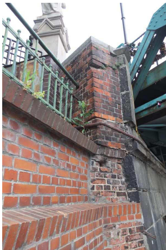
Fot. 18. Fragment muru na przyczółku zachodnim w zbliżeniu.
