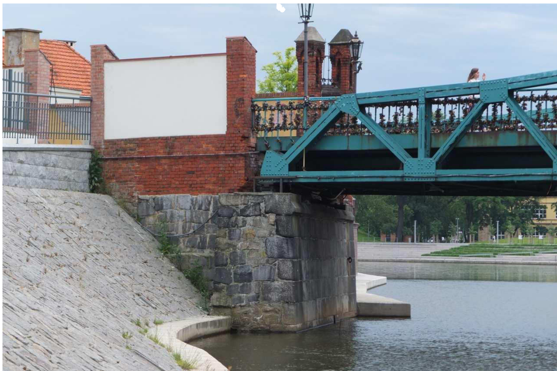
Fot. 20. Przyczółek wschodni od strony dolnej wody.
