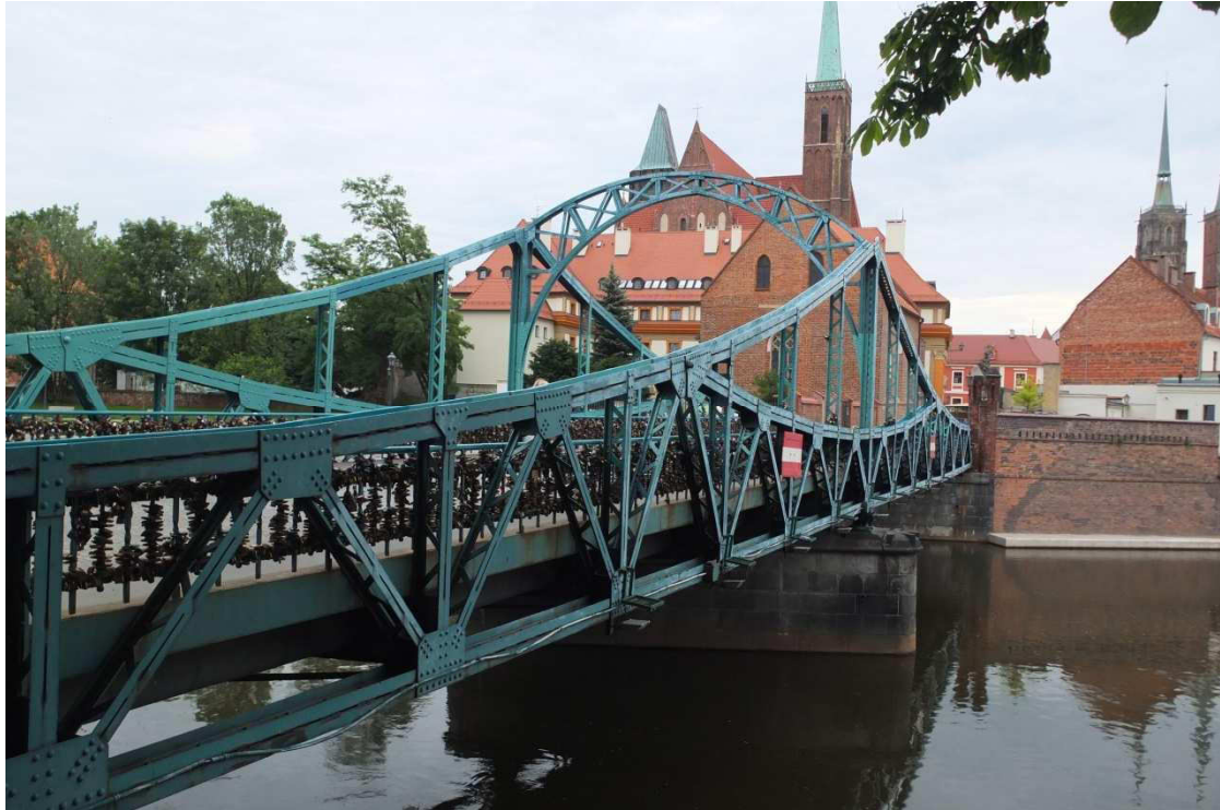
Fot. 11. Współczesny widok mostu od strony górnej wody.
