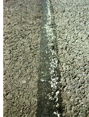
Rys. 4. Wykonanie złącza podłużnego metodą „gorące przy zimnym” bez zastosowania materiału uszczelniającego złącze, np. bez taśmy topliwiej (Sposób niezalecany na drogach publicznych. Może być stosowany tylko wyjątkowo za zgodą Inżyniera, np. na krótkich odcinkach lub w warunkach specjalnych)
