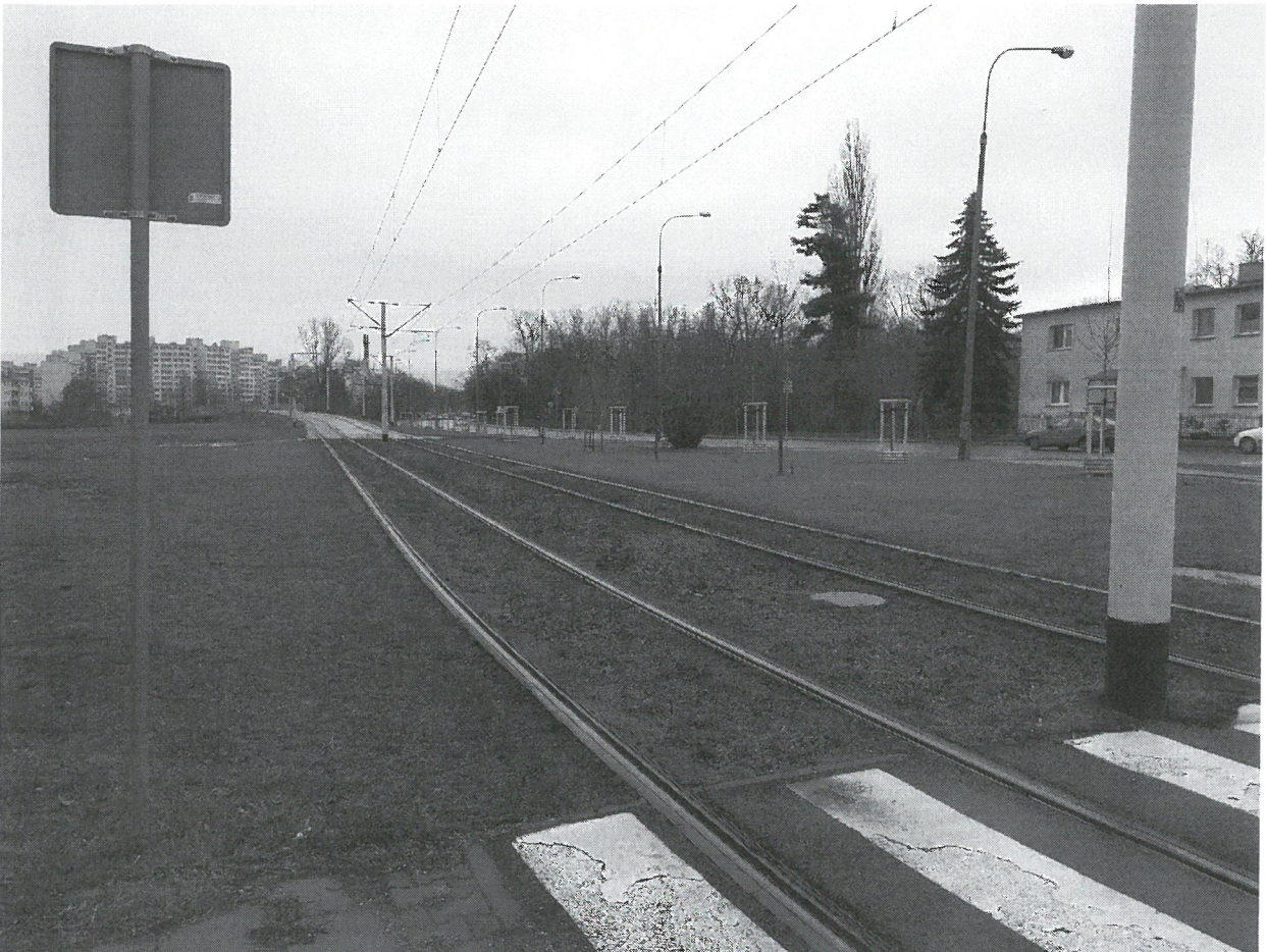
Zdjęcie nr 1 – Plan. lokalizacja przyst. tramwajowego – widok w kierunku mostu tramwajowego nad Ślężą
