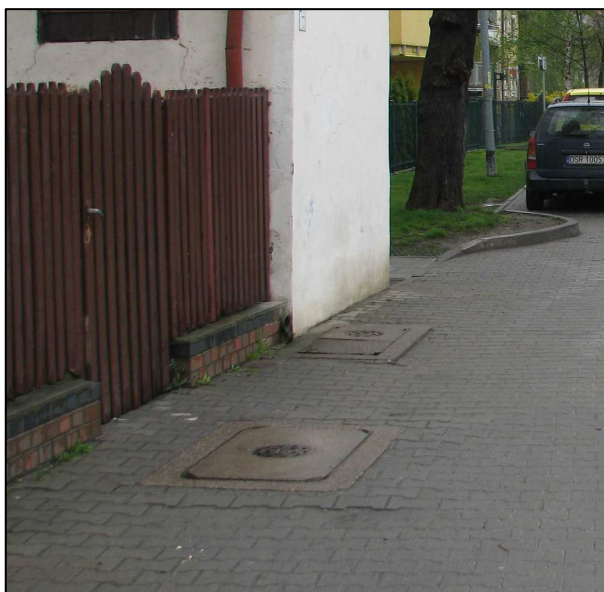
Istniejące studnie teletechniczne w obszarze działki 64, Obręb Klecina, AM-12
