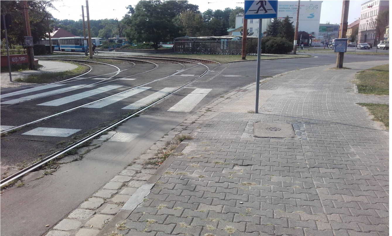
Slajd nr 2 – Dodatkowe przejście przez torowisko dla wysiadających na przystanku przed pętlą dla podróżnych kierujących się na południową stronę osiedla.
