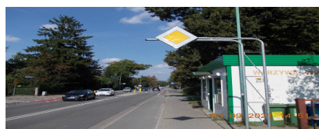
- montaż znaków dla zachowania poziomej skrajni drogowej z wysięgnikiem \geq 1 m
