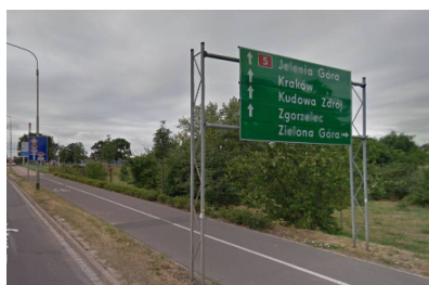
- montaż tablic dla zachowania poziomej/pionowej skrajni drogowej nad chodnikiem i drogą rowerową
