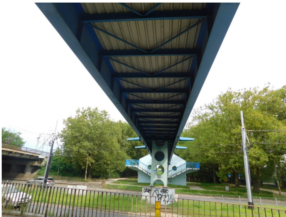
Fot. 3 Widok konstrukcji nośnej kładki od spodu z poziomu Al. Gen. J. Hallera.
