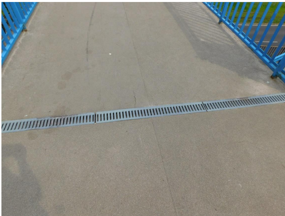
Fot. 7 .Widok przekrycia szczeliny dylatacyjnej.
