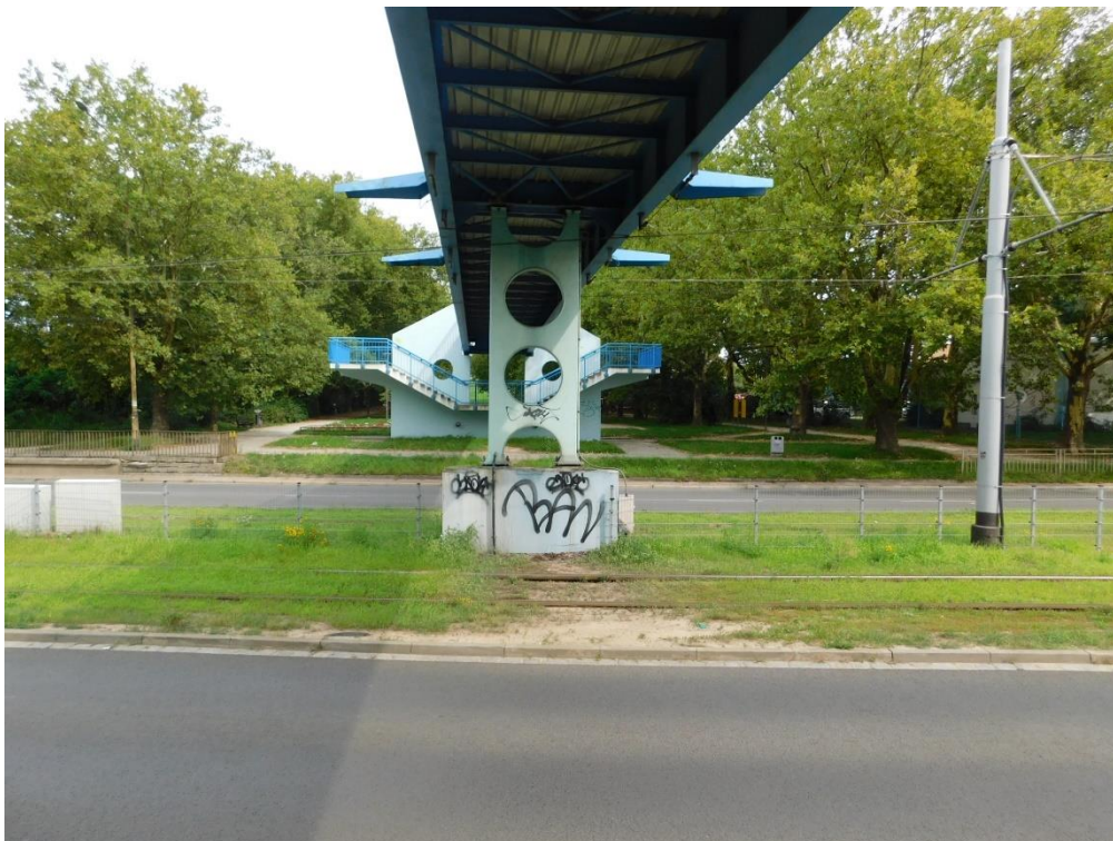
Fot. 5 Widok ogólny podpory pośredniej.
