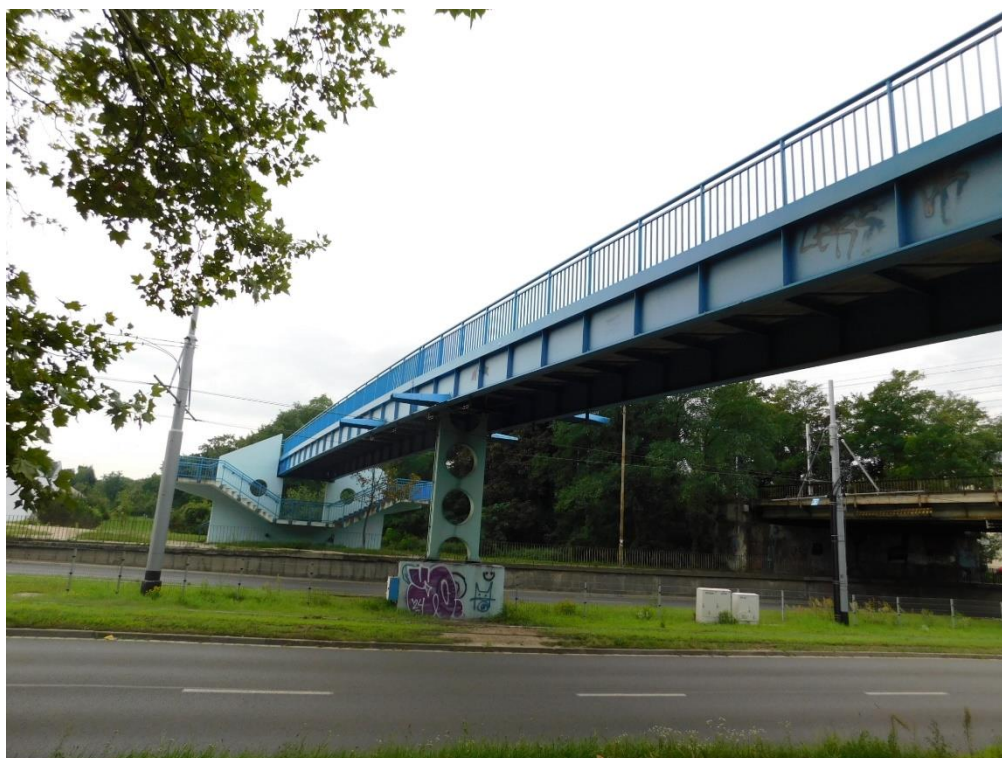
Fot. 2 . Widok kładki z boku od strony ul. Klecińskiej.
