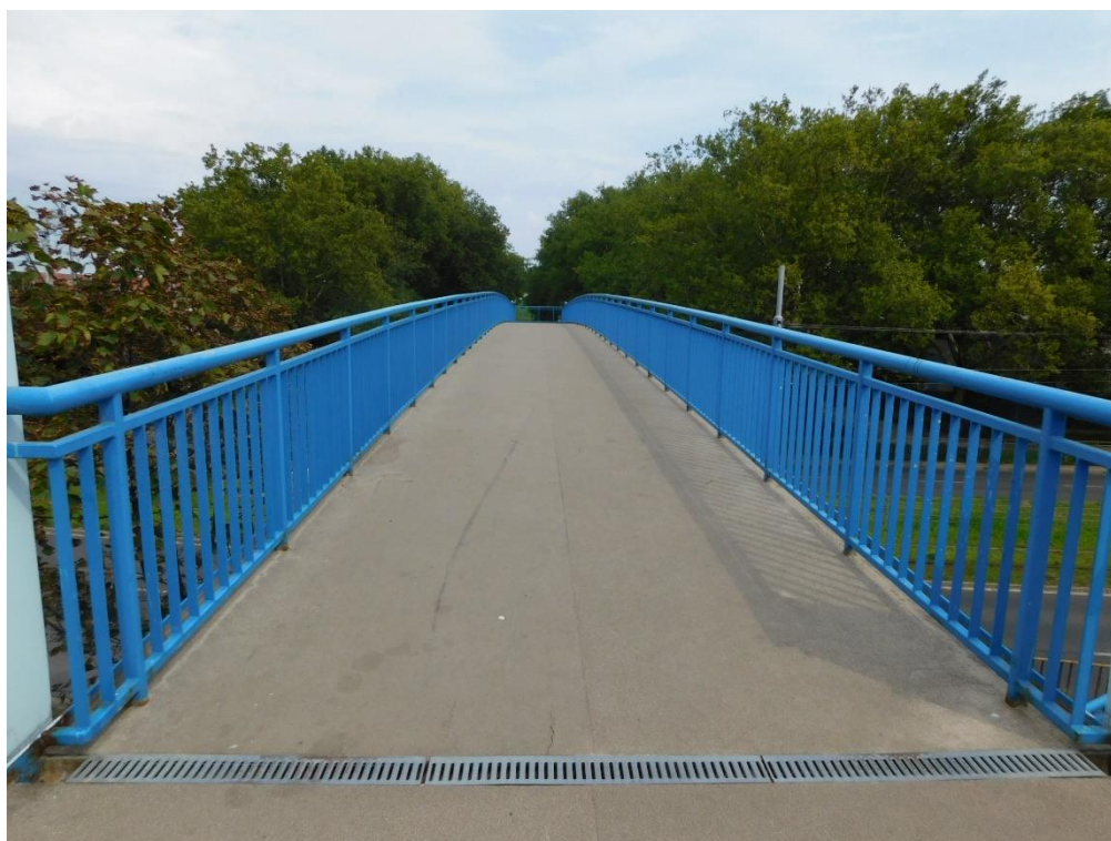
Fot. 6 Widok pomostu – widok od strony CH Borek.
