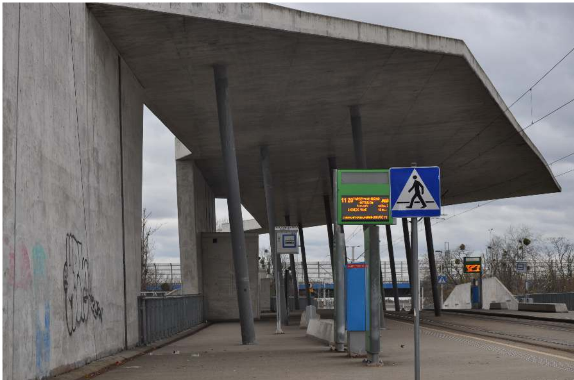
Rys. 4.1. Widok na zadaszenie od strony wschodniej
