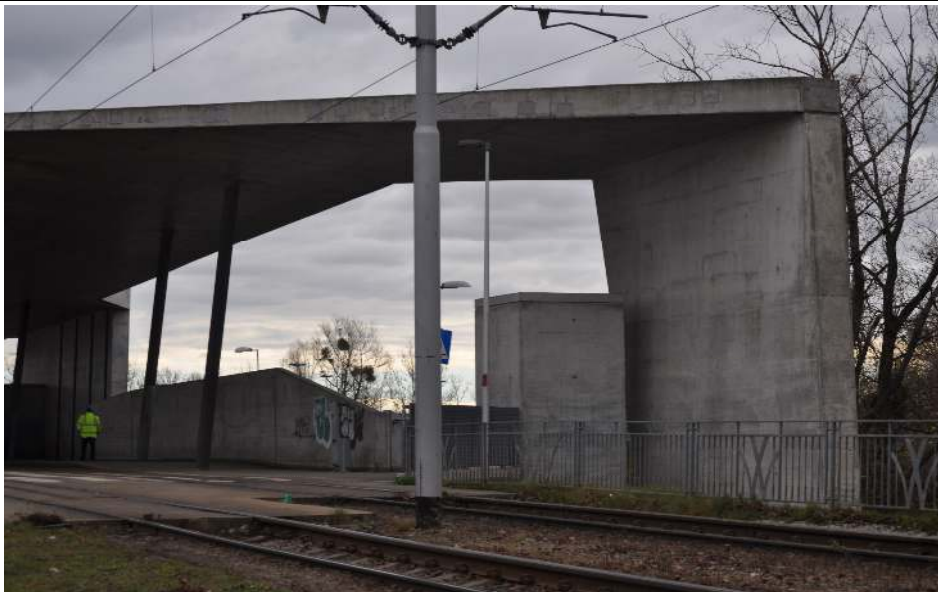
Fot. 3 Widok na zadaszenie oraz ścianę podpierającą od strony południowo-zachodniej
