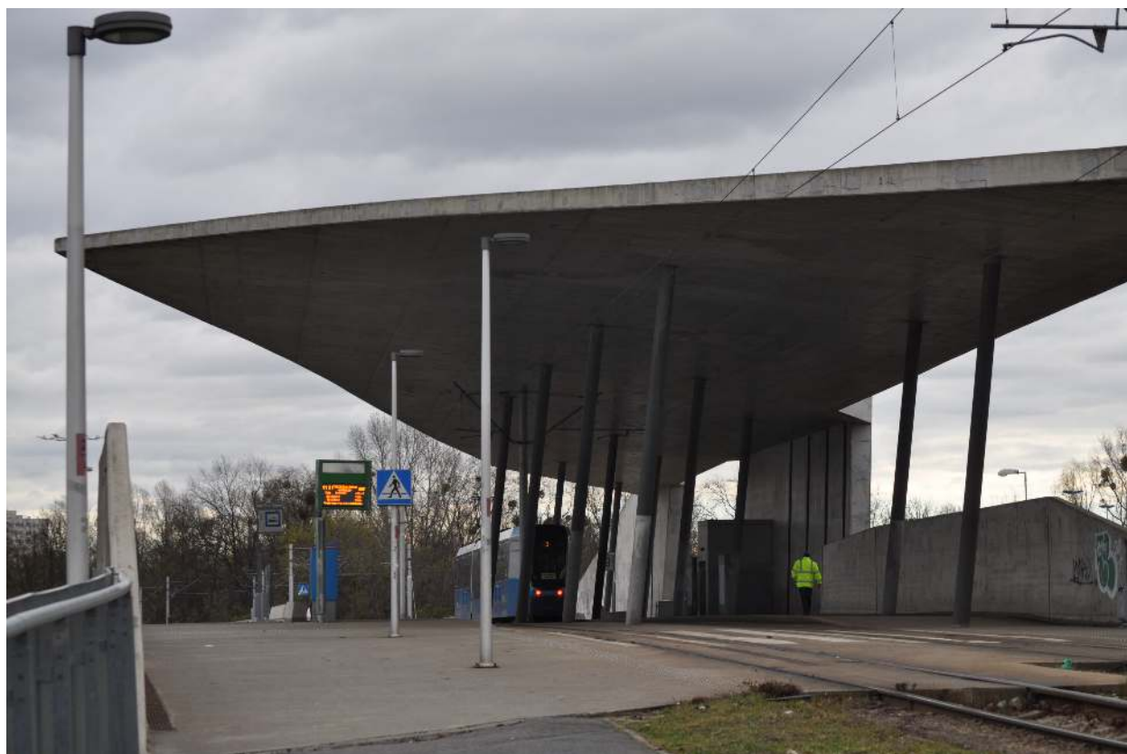
Rys. 4.3. Widok na zadaszenie od strony zachodniej
