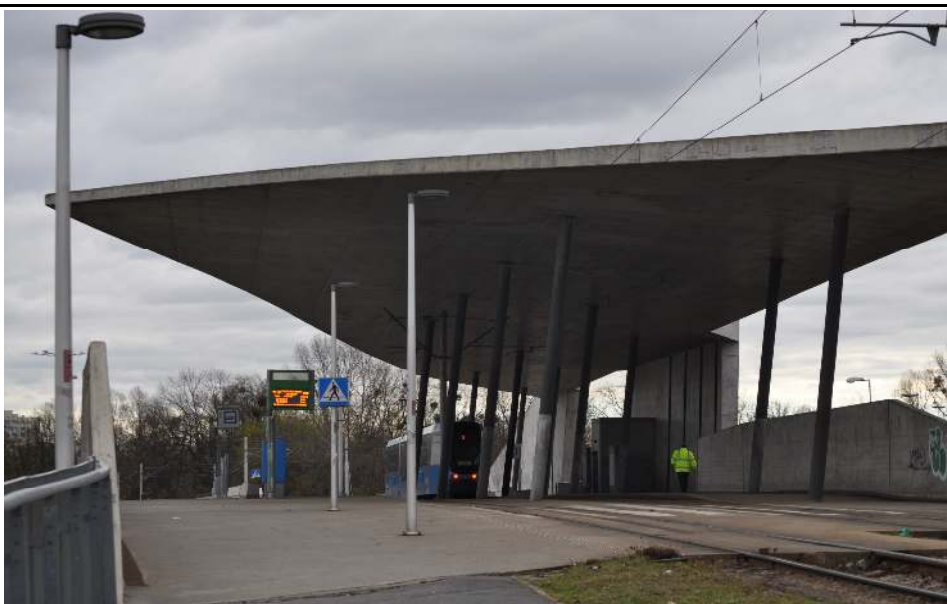
Fot. 4 Widok na zadaszenie oraz peron od strony zachodniej
