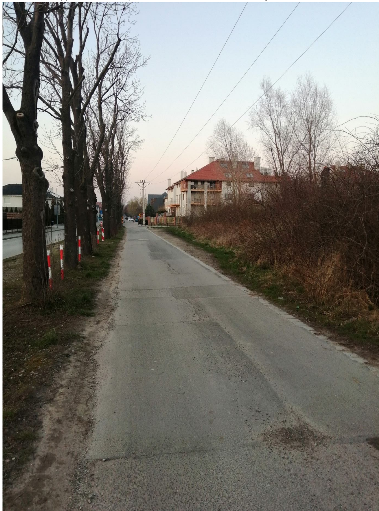
Zdjęcie 1 –widok od południa: odcinek od ul.Frankowskiego do ul.Kustronia
