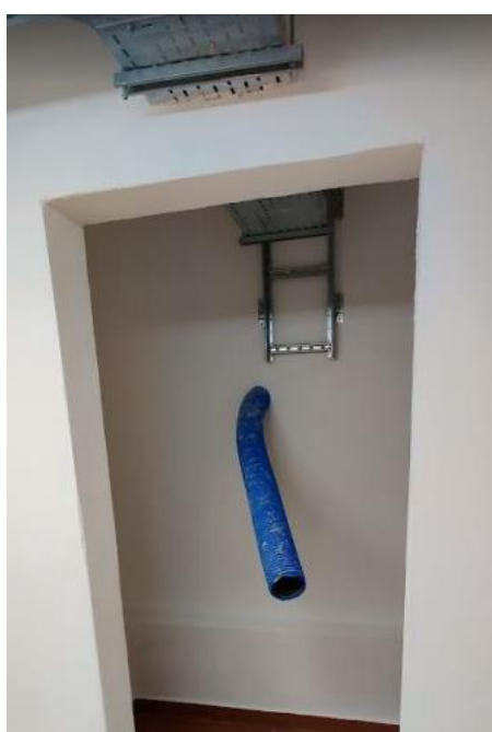
Rysunek 3 Widok rury osłonowej od strony schowka w piwnicy
