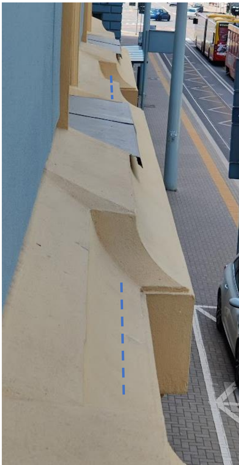
Rysunek 12 Miejsce montażu opraw na gzymsie dolnym
