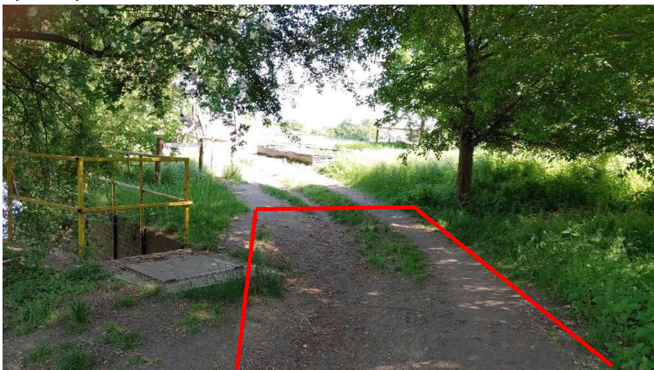
Zdjęcie Z19 – koniec proj. odcinka
