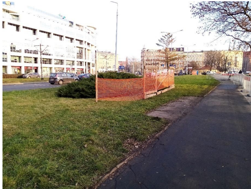
Fot. 1. Przykład wygrodzenia chroniącego grupę krzewów przed zasypaniem (Wykonanie i fotografie K. Barski).
