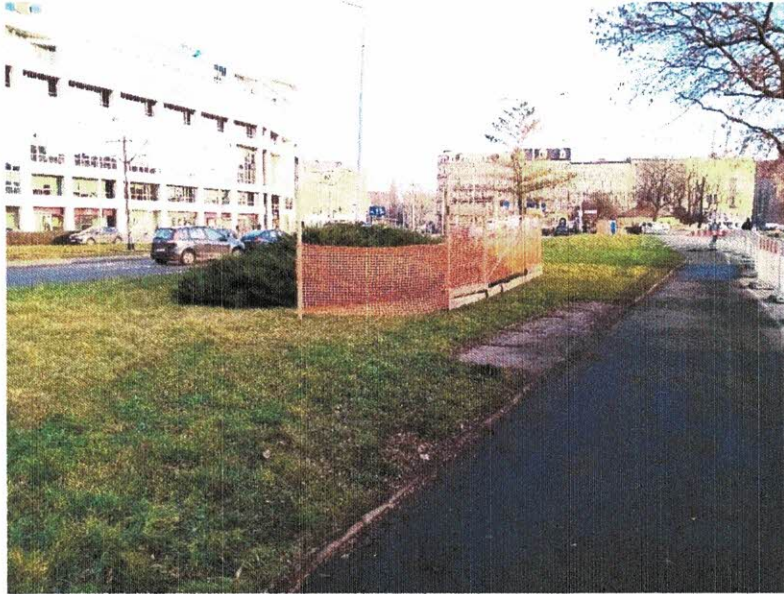
Fot. 1. Przykład wyгородzenia chroniącego grupy krzewów przed zasypaniem (Wykonanie i fotografie K. Barski).
