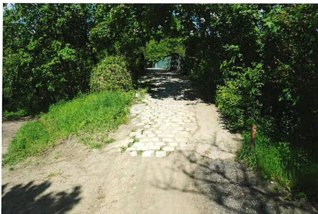
Fot.2. Widok ogólny dojścia do kładki patrząc od strony południowej.
