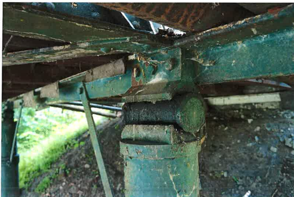
Fot.8. Widok ogólny łożysk – łożysko wałkowe.
