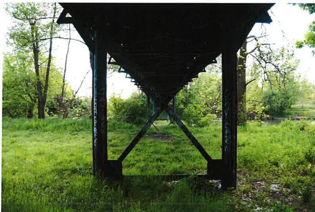
Fot.10. Widok ogólny – podpora nr 2
