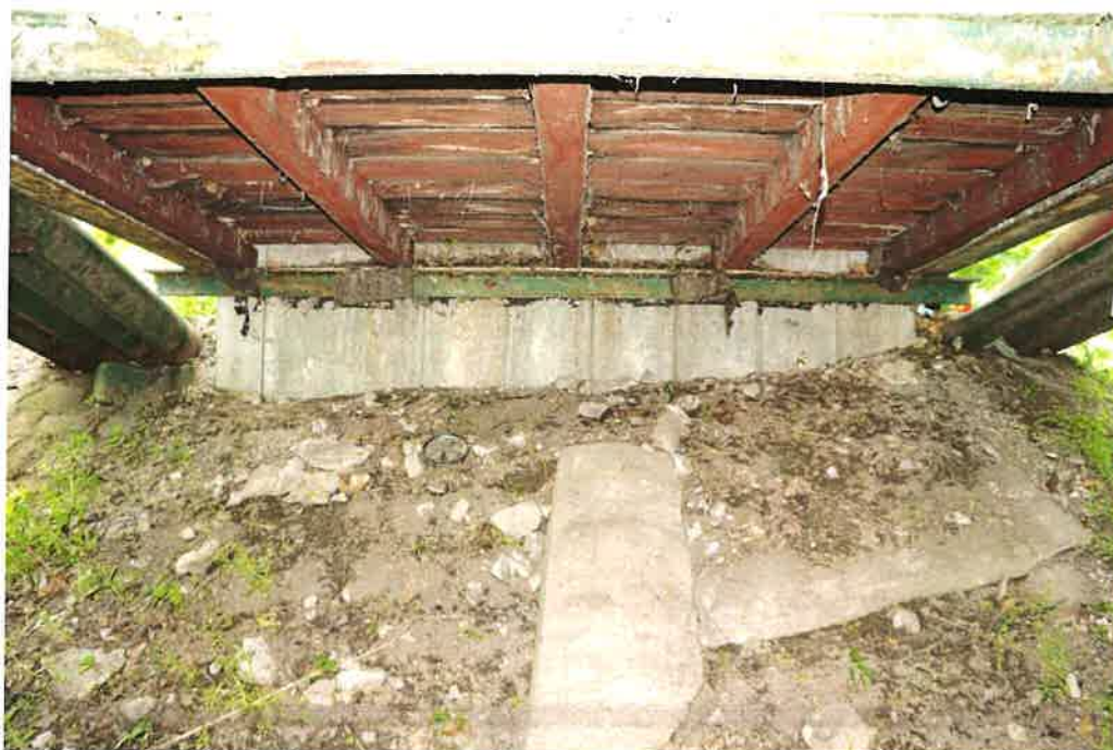
Fot.6. Widok ogólny – przyczółek po stronie północnej.
