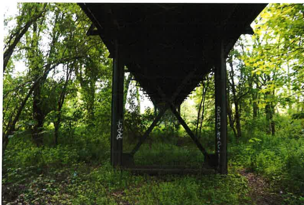
Fot.9. Widok ogólny – podpora nr 1
