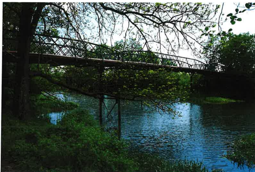
Fot.3. Widok ogólny kładki patrząc od strony dolnej wody.
