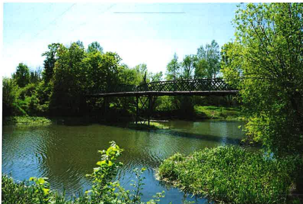
Fot.4. Widok ogólny kładki patrząc od strony górnej wody.
