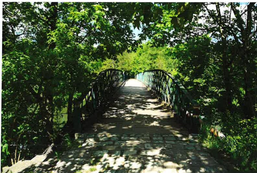
Fot.1. Widok ogólny dojścia do kładki patrząc od strony północnej.
