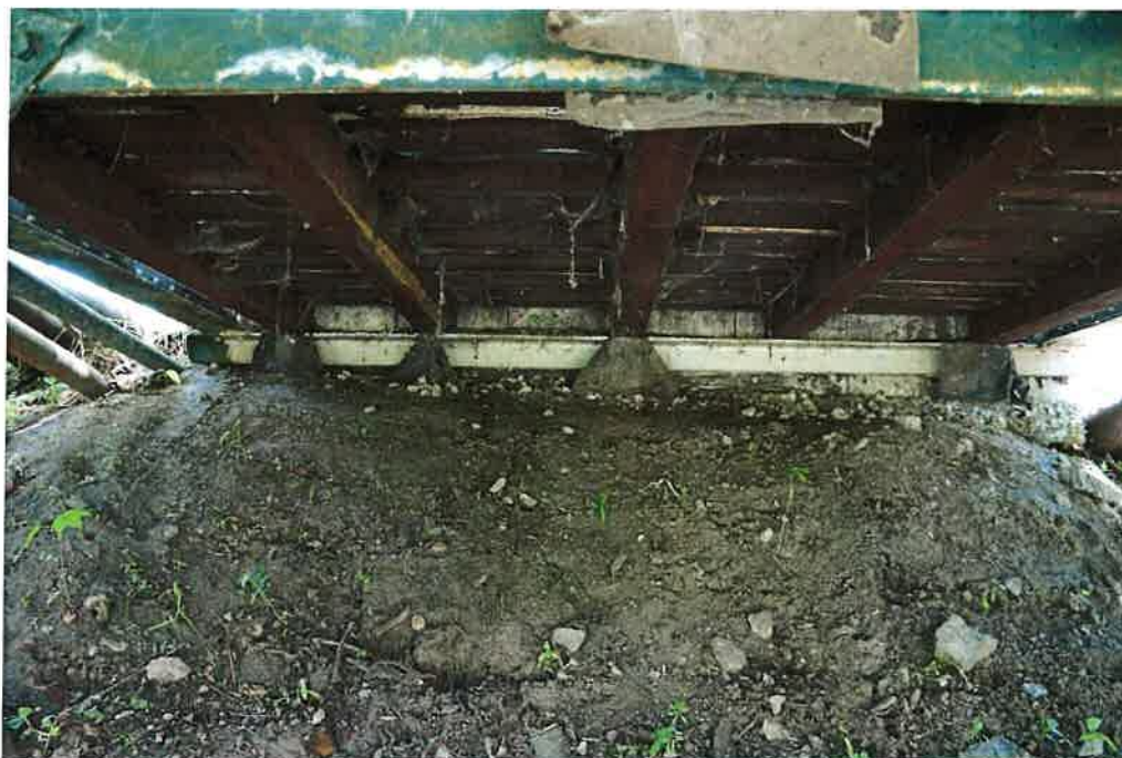
Fot.7. Widok ogólny – przyciółek po stronie południowej.
