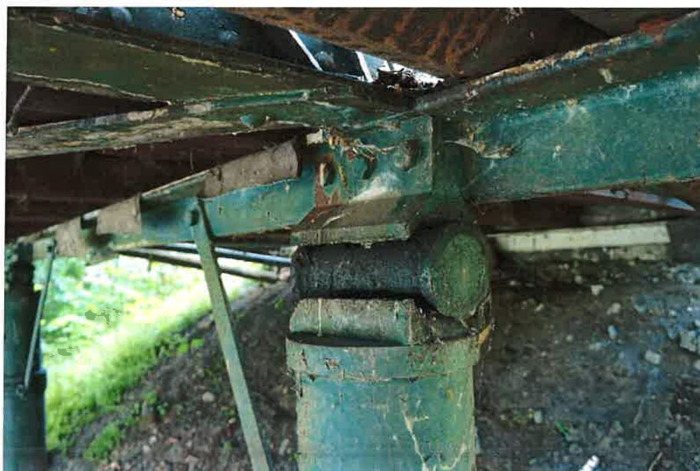
Fot.8. Widok ogólny łożysk – łożysko wałkowe.
