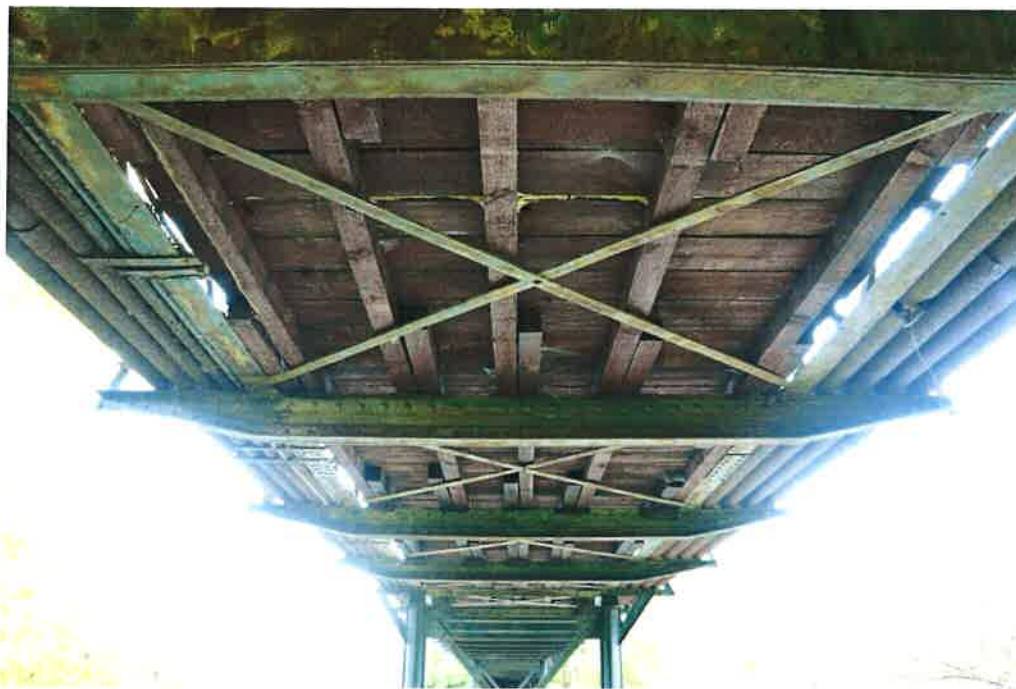
Fot.5. Widok ogólny spodu konstrukcji.
